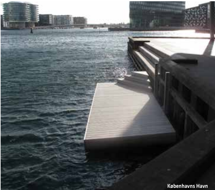
5.A Adgang og ophold med ponton
