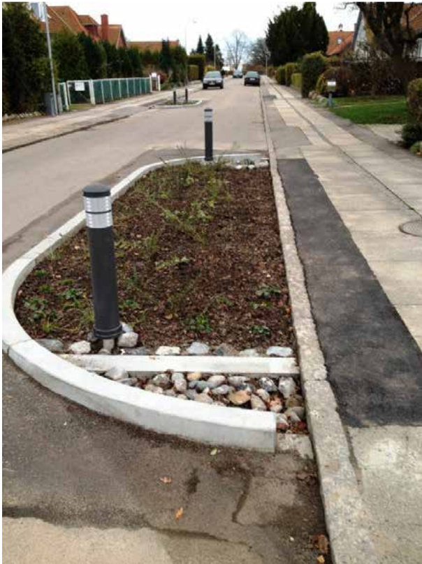
Kantstensbed til opsamling rensning og nedsivning af vejvand. Lokalitet: Lindevang, en villavej i Brøndby. Foto: Simon Toft Ingvertsen
