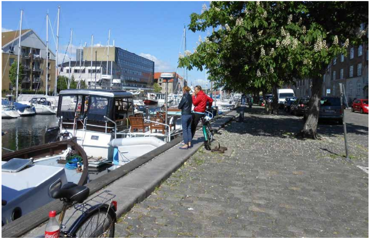
Billede fra Christianshavn hvor det ses at der er kant langs kanalen og at hældningen skræner væk fra vandet. Foto: Ezra Rémy.
