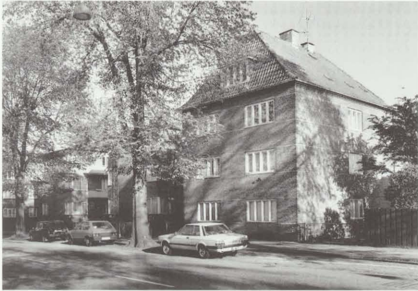
En særlig form for "parkbebyggelse" udgør de små private udlejningsejendomme, som i 1930'erne ikke mere lægges i gadelinien. Ved Frederiksborgvej ligger en lille gruppe indbyrdes forskellige huse af denne art. (Frederiksborgvej 228 mfl., opf. 1931-36).
