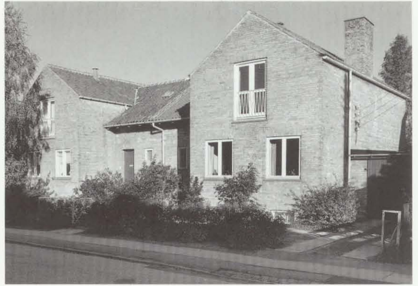
En lille rækkehusbebyggelse ved Pragstjernevej (opf. 1947) repræsenterer en kendt type fra efterkrigsårene. Med de to etager og den høje trempel udnyttes husets volumen godt, og de sammensatte bygningsformer skaber et levende helhedsbillede.
