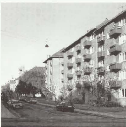
Frimestervej, set mod nord
