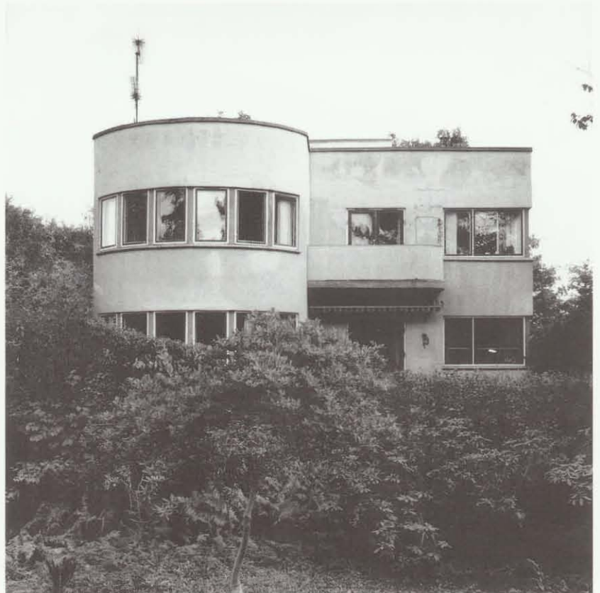
Den funktionalistiske énfamiliebolig er kun sjældent forekommende, og da næsten kun i form af store villaer. Bomhusvej 7 A (opf. 1934) er et stilsikkert eksempel med den halvrunde havestue, den store balkon og hjørnevinduerne.
