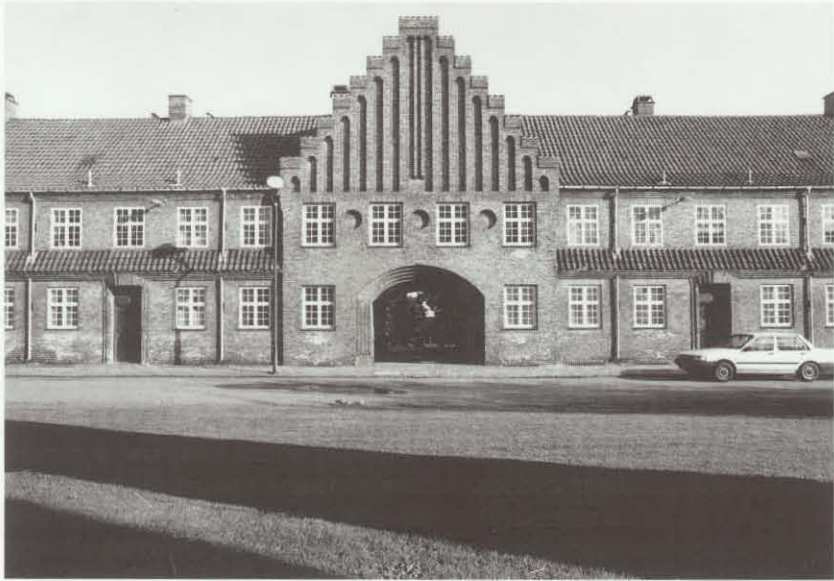
Port mod Peter Rørdams Vej, set mod øst
