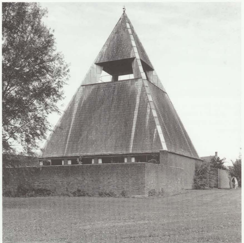
Lundehuskirken var en nyskabelse, som fik stor betydning for dansk kirkebyggeri. Den pyramideformede kirkebygning med det integrerede klokketårn danner sammen med de lave bygninger til menighedslokaler en sluttet komposition (opf. 1957 af Holger Jensen).
