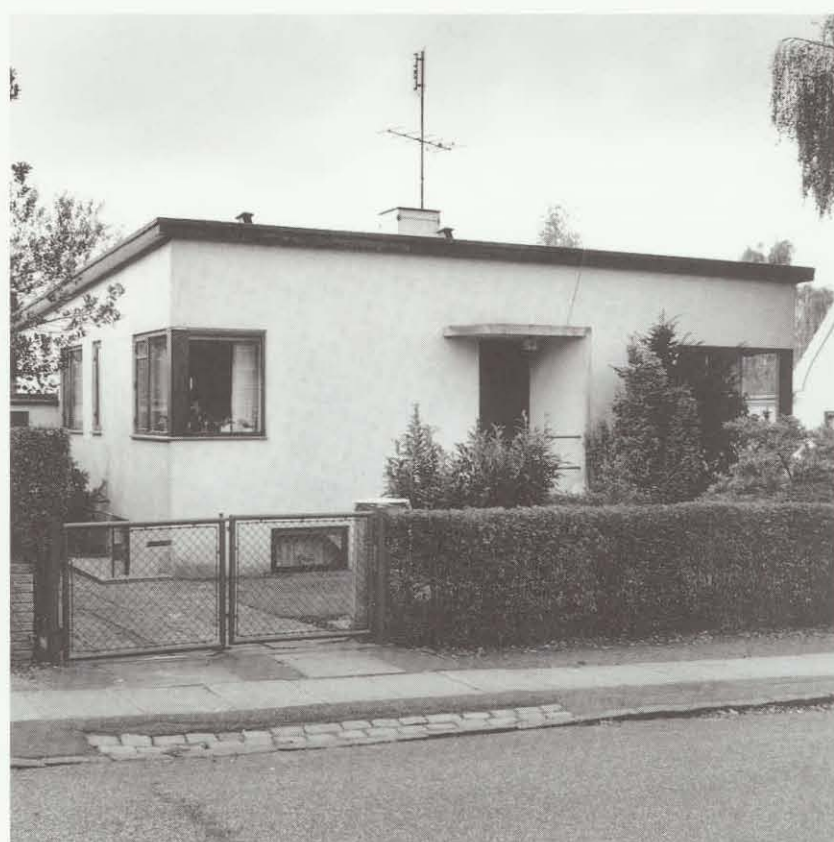
1930'ernes funkishuse var et barn af funktionalismen. På Dalmosevej 5 (opf. 1934) finder man de typiske træk, det flade tag, den pudsede facade (en efterligning af betonhusene), hjørnevinduerne og baldakinen ved hoveddøren.
