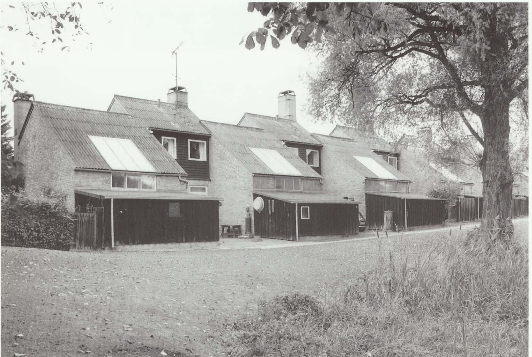
Atelierhusene på Grønnemose Allé (opf. 1943 af Viggo Møller-Jensen) er en meget fin, lille rækkehusbebyggelse beregnet for billedkunstnere. Husene er enkle og billige, men danner alligevel med deres forskydninger og huggegårde en levende helhed.
