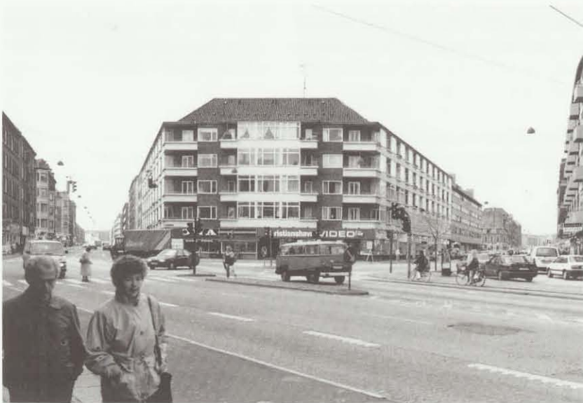
Frederikssundsvej ved Frederiksborgvej, set mod nord
