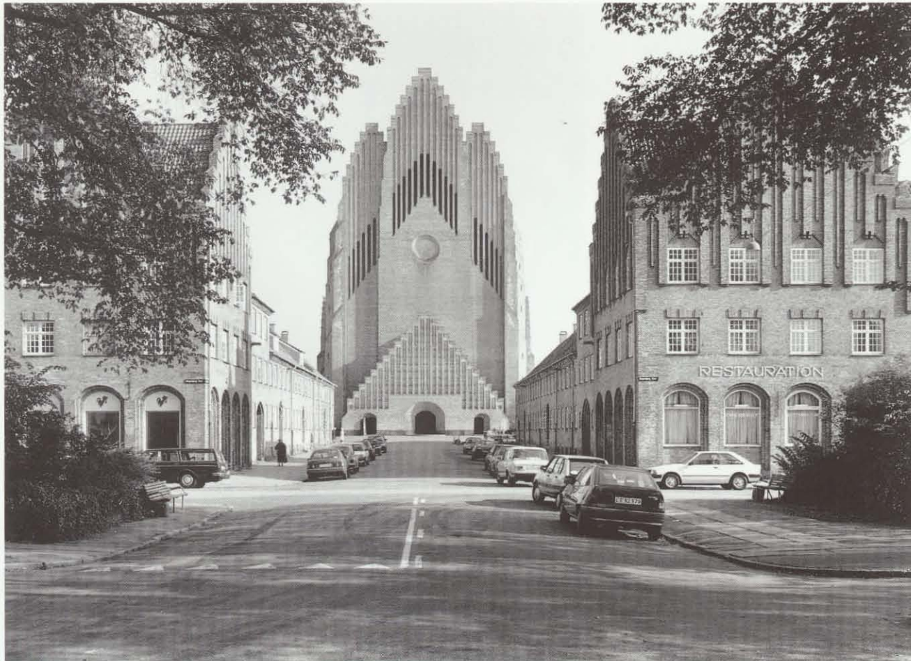
Grundtvigs Kirke opleves med sin beliggenhed højt på Bispebjerg som bydelens vigtigste punkt. Arkitektonisk er den et af århundredets hovedværker (opf. 1921-1940 af P. V. Jensen Klint og Kaare Klint). Se omtalen af kirken og det omgivende kvarter side 10 og 22.
