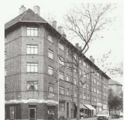
Tomsgårdsvej, set mod nord
