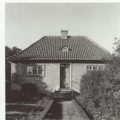
Solrødvej 15 (opført i 1931) er et pudset hus med tegl på et stejlt, afvalmet tag. Huset er symmetrisk opbygget omkring indgangsdøren. Lave klippede hække leder op til huset. Et stilfærdigt hus med klassicistiske detaljer.
