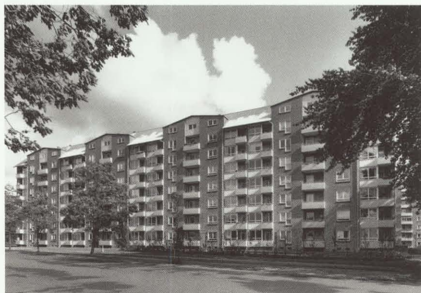
Kobbelvænget 1 er en del af etageboligbebyggelsen Voldparken. Bebyggelsen er tegnet af arkitekterne Edvard Heiberg og Karl Larsen og opført i 1949. De syv-etages blokke er opdelt i markante lodrette facadestykker, hvor balkonmotivet er et gennemgående træk. Dele af facaden er udført i tegl, afsluttende med en facadekvist.
