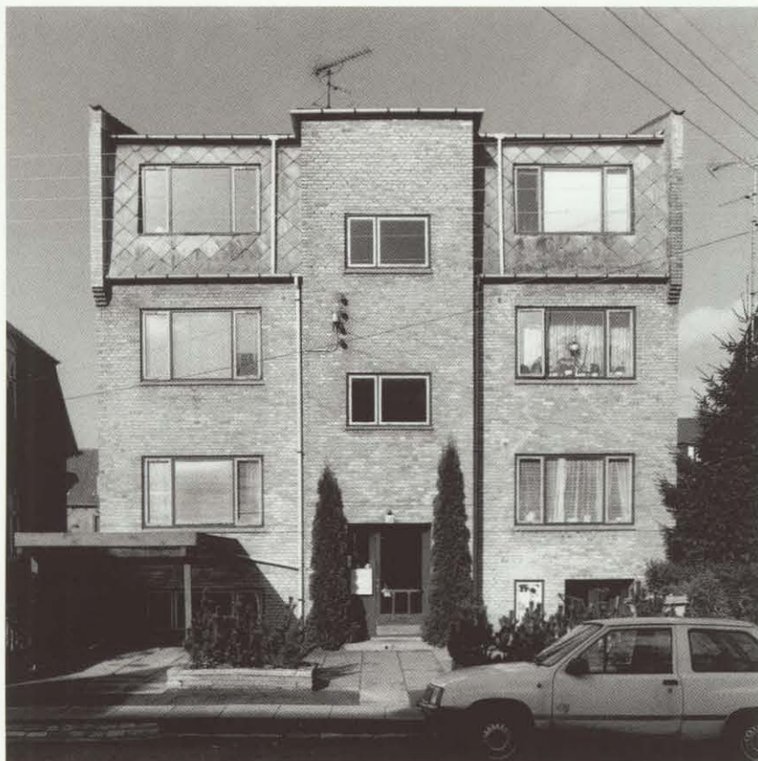
Hvalsøvej 12 er en mindre etageejendom opført i 1939. Huset, der er funktionalistisk inspireret, er symmetrisk opbygget omkring indgangsparti og trappeopgang. Facaden er i blank mur og huset afsluttes med en relativt tung mansardetage beklædt med eternit. Indgangspartiet markeres af to thujatræer.
