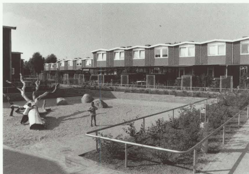
Bebyggelsens centrale gårdrum er bl.a. indrettet med forsænkede legepladser.
