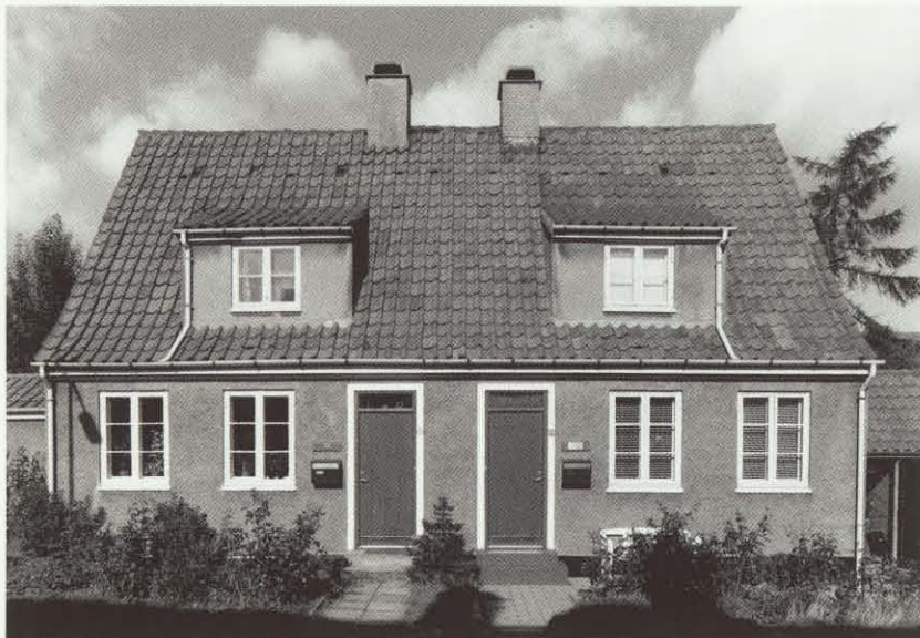
Egevangen 12-14 er opført i 1923 som en del af „Den Engelske Haveby“. Arkitekt Niels Gotenborg har tegnet de engelsk inspirerede huse. De små sammenbyggede tofamiliehuse er i en etage med udnyttet tagetage. Facaderne er pudsede, symmetrisk opdelt og meget enkle, kun omkring døren er der en smal indramning. De enkelte huse er stilfærdige i udtrykket, og som bebyggelse er kvarteret unikt.
