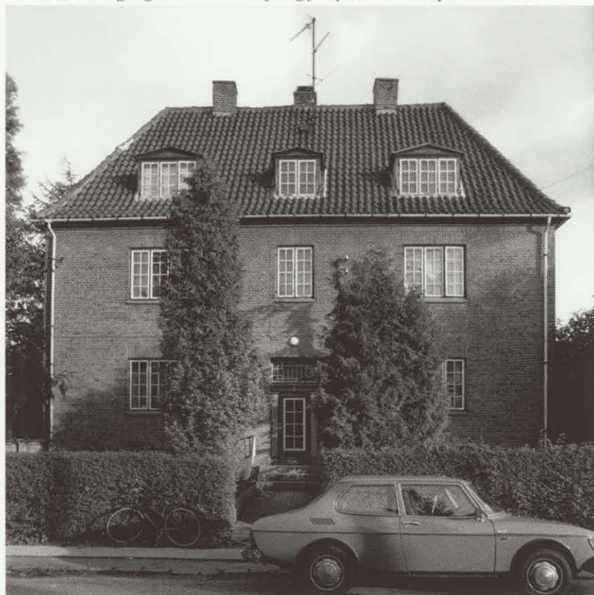
Tølløsevej 33 er opført i 1932. En gedigen nøgtern rødstensvejendom med klassicistiske træk. Huset er symmetrisk opbygget med et smukt, originalt indgangsparti i midteraksen. Tegltaget er relativt stejlt og forsynet med tre spinkle kviste.
