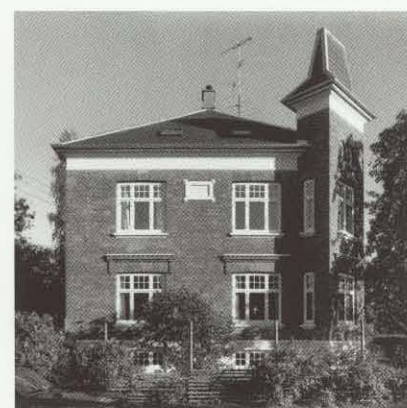
Hvalsøvej 35 er en flerfamilievilla opført i 1905. Et gedigent hus i blank mur med skifer på pyramidetaget. Huset er smykket med et tårn på det ene hjørne og forsynet med dekorationer over vinduerne. En tæt og velproportioneret bygningskrop med fine detaljer.
