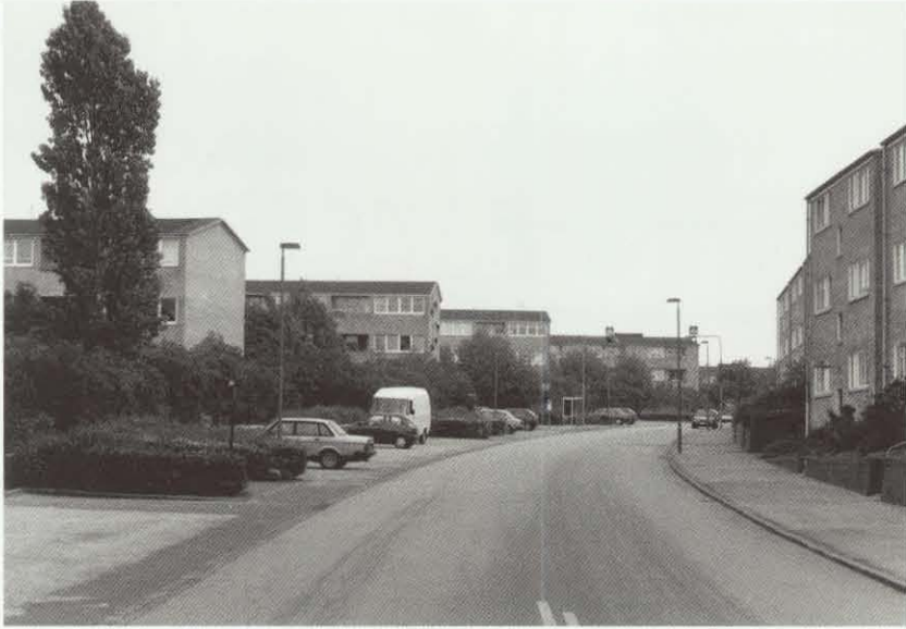
Tingbjerg er tegnet af arkitekt Steen Eiler Rasmussen. Byggeriet blev påbegyndt i 1956 og blev afsluttet i 1970'erne. Blokkene er opført i tre etager i gule sten med et relativt fladt saddeltag beklædt med tagpap. Fotoet viser Gavlhussvej set mod øst.
