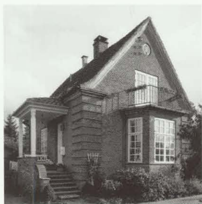
Løvetandsvej 60 er opført i 1930 med blank mur og teglstenstag. Gavlen er smukt symmetrisk opbygget med altankarnap i aksen. Indgangen er markeret med et fint lille søjlebåret halvtag. Et smukt hus i "Bedre Byggeskik" tilsat historicistiske træk.
