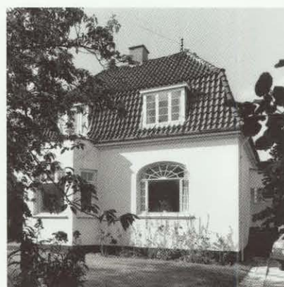
Havrevej 17 er opført i 1916. Huset er pudset og forsynet med mansardetage og stejlt afvalmet tegtag. Facaden prydes af karnap med altan. Vinduesudformningen er jugendinspireret.
