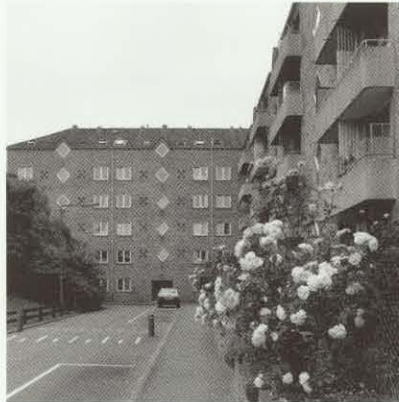
Rolandsgård set mod sydvest. Stueetagens terrasser er placeret på et forhøjet niveau.
