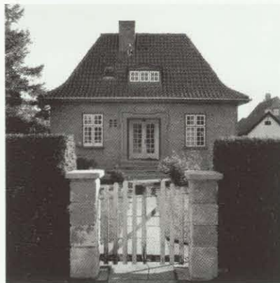
Veksøvej 175 er opført i 1932. Villaen er opført i blank mur med et stejlt opskalket tegltag. Facaden er symmetrisk opbygget omkring et dominerende indgangsparti med barokindfatning. En fin, sluttet bygningskrop med et markant facadeudtryk.
