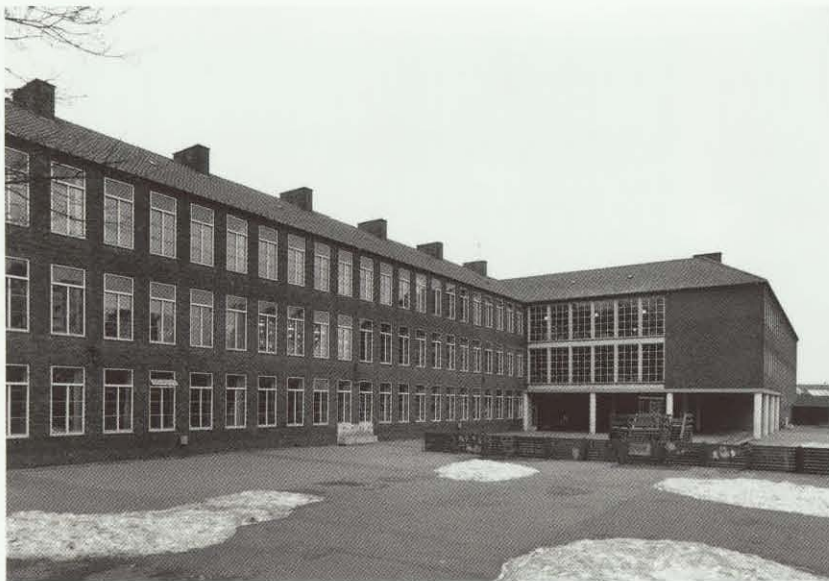
Bellahøj Skole set fra nord. Facadeindtrykket domineres af de store vinduespartier.
