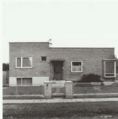
Brønshøj Kirkevej 30 - en funktionalistisk villa opført i 1937. Villaen er opført i gule sten og har fladt tag. Markeringen omkring indgangspartiet og hjørnevinduet er typiske funktionalistiske træk. Stakittet med murede piller og jernrækværk passer fint huset. Et enkelt hus med et nøgternt udtryk.
