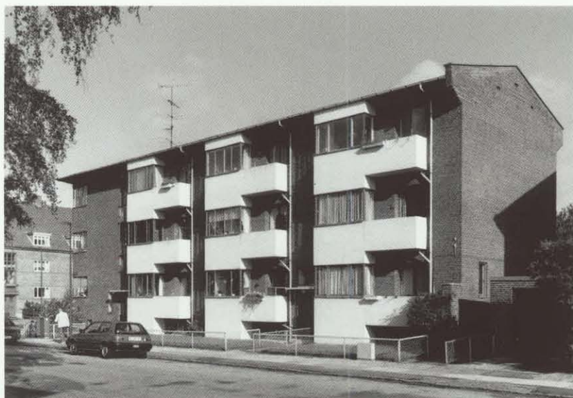
Fjenneslevvej 22 er opført i 1935. Den funktionalistiske hjørneejendom har en markant lodret facadeopdeling. Altan-karnapmotivet, hjørnevinduerne og halvtaget over indgangsdørene viser tydeligt i hvilken tid huset er bygget. Et gedigent hus med et veldefineret facadeudtryk.
