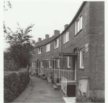
Humlevænget set mod sydøst. Den buede bygning formidler overgangen mellem rækkehusområderne. Indgangspartierne er udført i så spinkle materialer, at de næsten svæver.
