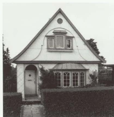
Dalvangen 45 er opført i 1932. Bygningens gavl er beklædt med eternit, i stueplan diagonallagt, og taget er belagt med skifer. Facaden domineres af en stor karnap med fine vinduer, og indgangspartiet er trukket tilbage i forhold til facaden.
