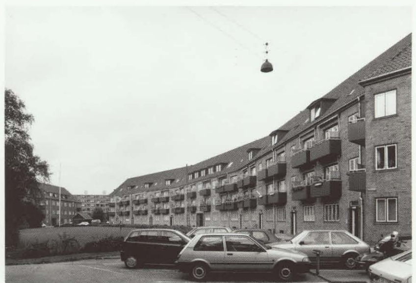
Parkstykket er en større bebyggelse opført af Arbejdernes Andels-Boligforening i 1936 og tegnet af arkitekterne Louis Hygum og Carl Jørgensen. Dele af bebyggelsen er smukt anlagt omkring en oval grønning. Blokkene er enkle, opført i røde sten med afvalmede tage. Facadeudtrykket domineres af altanernes vandrette linier.
