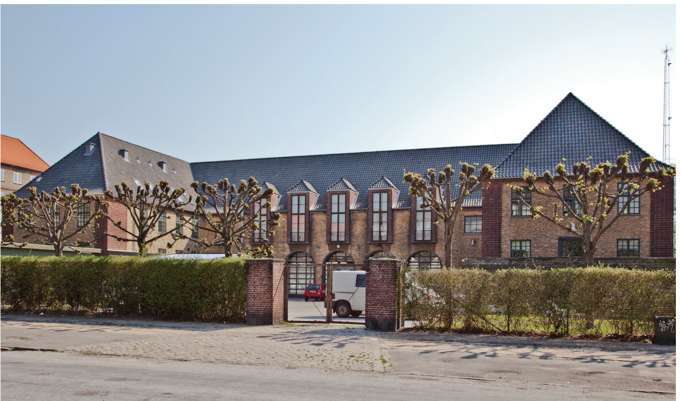
Brandstationen med de karakteristiske vinduer der skyder op i taget.
