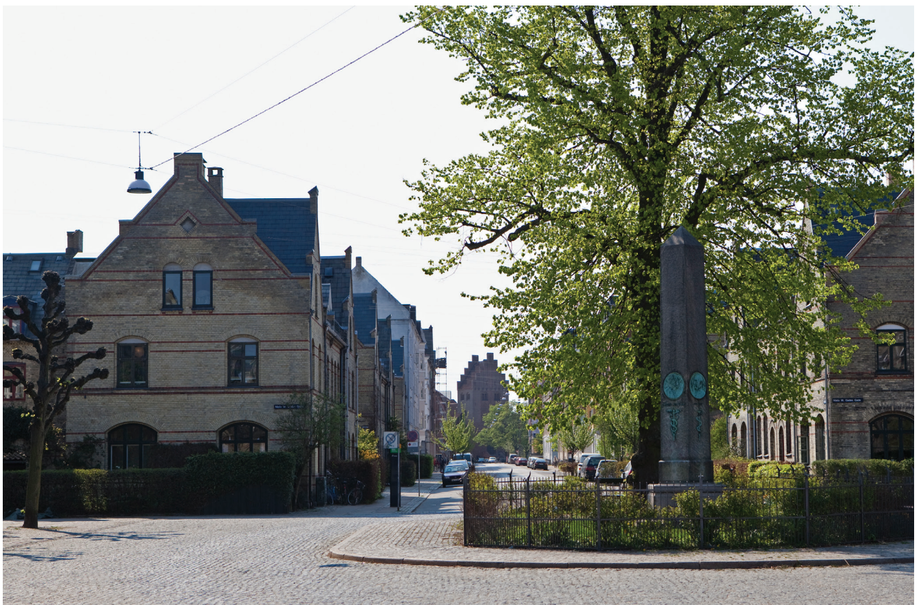
Pladsen på Kildevældsgade set mod vest med Kildevældskirken for enden
