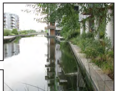
Multibane udformet som forsækning i terrænet til skybrud
