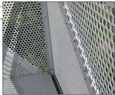
Perforede stålplader på altanerne
