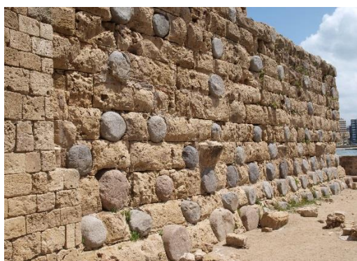
Figur 1. Genbrug af granitsøjler i mur, fæstningen i Sidon, Libanon.
