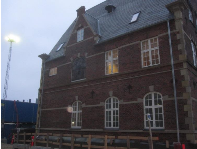
Figur 9. Ny facade på Carlsbergs på gamle administrationsbygning.
