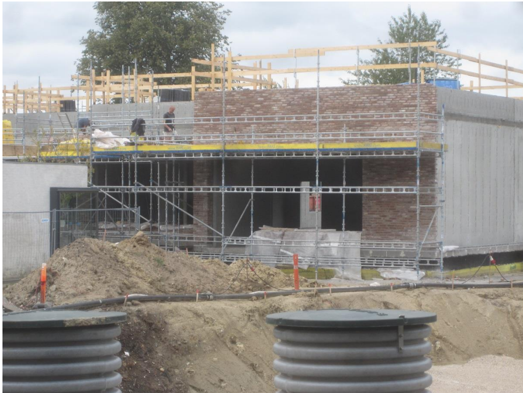
Figur 18. Opførelse af ny bygning, KATFRIT, på Katrinedals Skole, Vanløse med facade af genbrugssten, september 2015.
