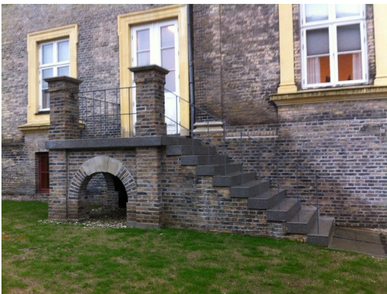
Figur 11. Genbygget trappe på et Grå Hus med genbrugssten.
