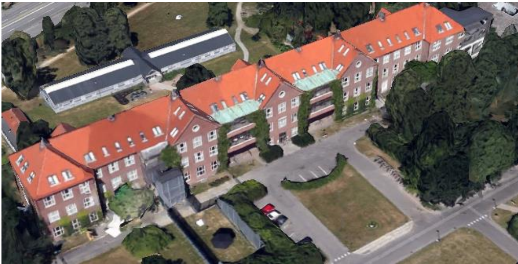
Figur 17. Bygning 13. Bispebjerg hospital (Foto Google Earth).
