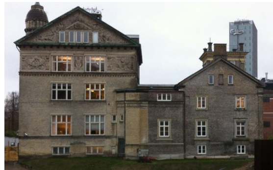
Figur 10. Den fredede bygning, Det Grå Hus, før renovering (tv) og efter renovering med genbrugte mursten (th) fra den nedrevne nabobygning, Søndermarkshus.
