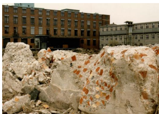
Figur 2. Betonfundament med tilslag af nedknust beton. Nedrivning af NKT Kabelfabrik 1985.
