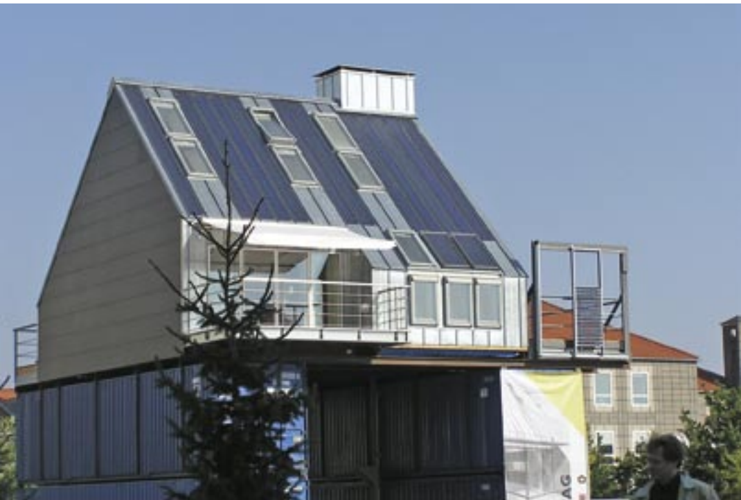
◀ Prototype på klimaoptimeret tagbolig i lavenergiklasse 1. Boligen er konstrueret med stor lufttæthed, uden kuldebroer samt med ventilation med effektiv varmegenindvinding. Der er desuden solvarmeanlæg til varmt brugs- vand samt et mindre solcelleanlæg. Se: www.soltag.net
