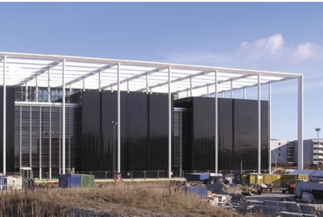
◀ IT-tunge erhvervsbygninger har ofte et stort behov for køling. I DR byen er der udført et hybridanlæg med frikøling (udeluft), grundvands- køling og kompressorkøling. Grundvandskølin- gen, der drives af et solcelleanlæg på 1.200 m², bruges om sommeren, når udeluften er for varm. Om vinteren genkøles grundvandslageret med kold udeluft. Se: www.dr.dk/drbyen
