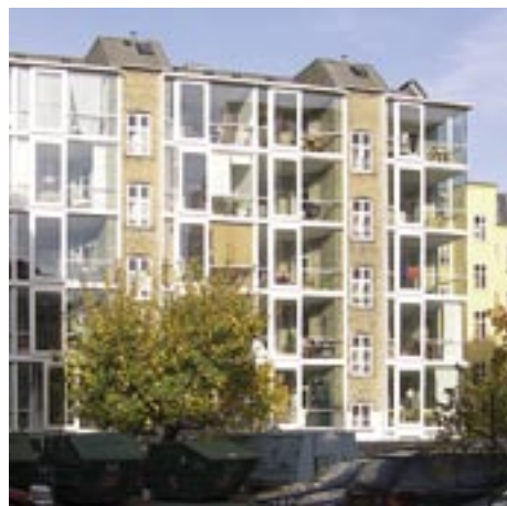
I AB Carls Have, Vesterbrogade 127, giver en ny frem-skudt glasfacade mellem trappetårnene både større boliger og varmeakkumulering i de tidligere ydervægge.
