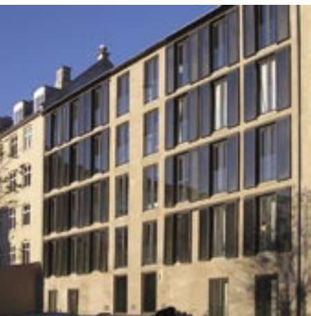
Solskodder, Istedgade 43, fungerer både som isolering, solafskærmning og luftsolfangere.
