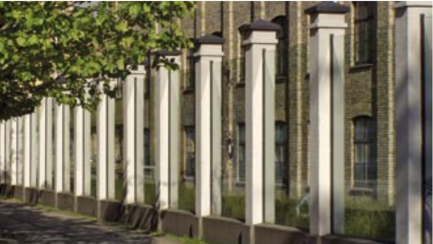
Støjskærm, Smallegade 45, med tykt hærdet glas, der erstatter et tidligere gitterværk. Foruden fin arkitektonisk udførelse, lys og åbenhed, er støjdæmpningen på 10 -15dB(A).
