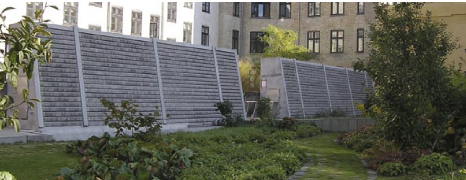
”Synlig ressourcebalance” i Hestetalskarreen på Vesterbro. Teknikkanaler markeres visuelt af pyloner gennem karreen. Pylonerne er udført af specialfremstillede genbrugssten af nedknust gul tegl indstøbt i grå beton
