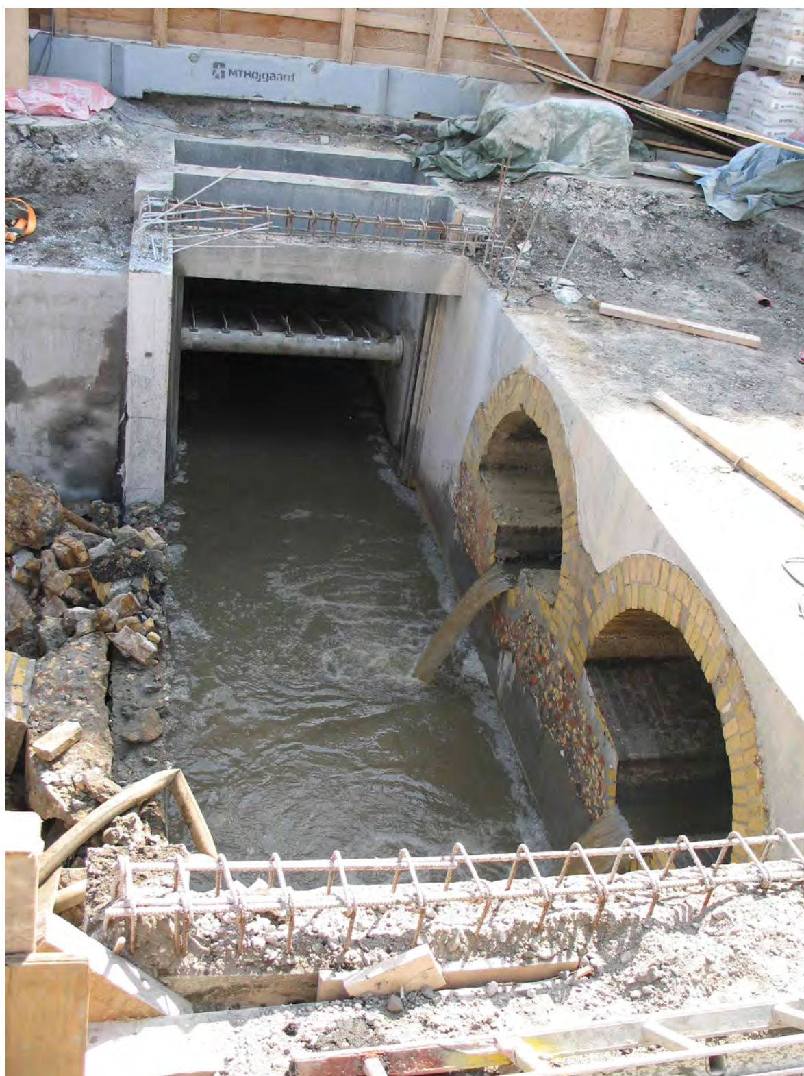
Foto 10 Gammel muret dobbeltledning, anlægsarbejder i forbindelse med Sankt Annæ Plads-projektet
