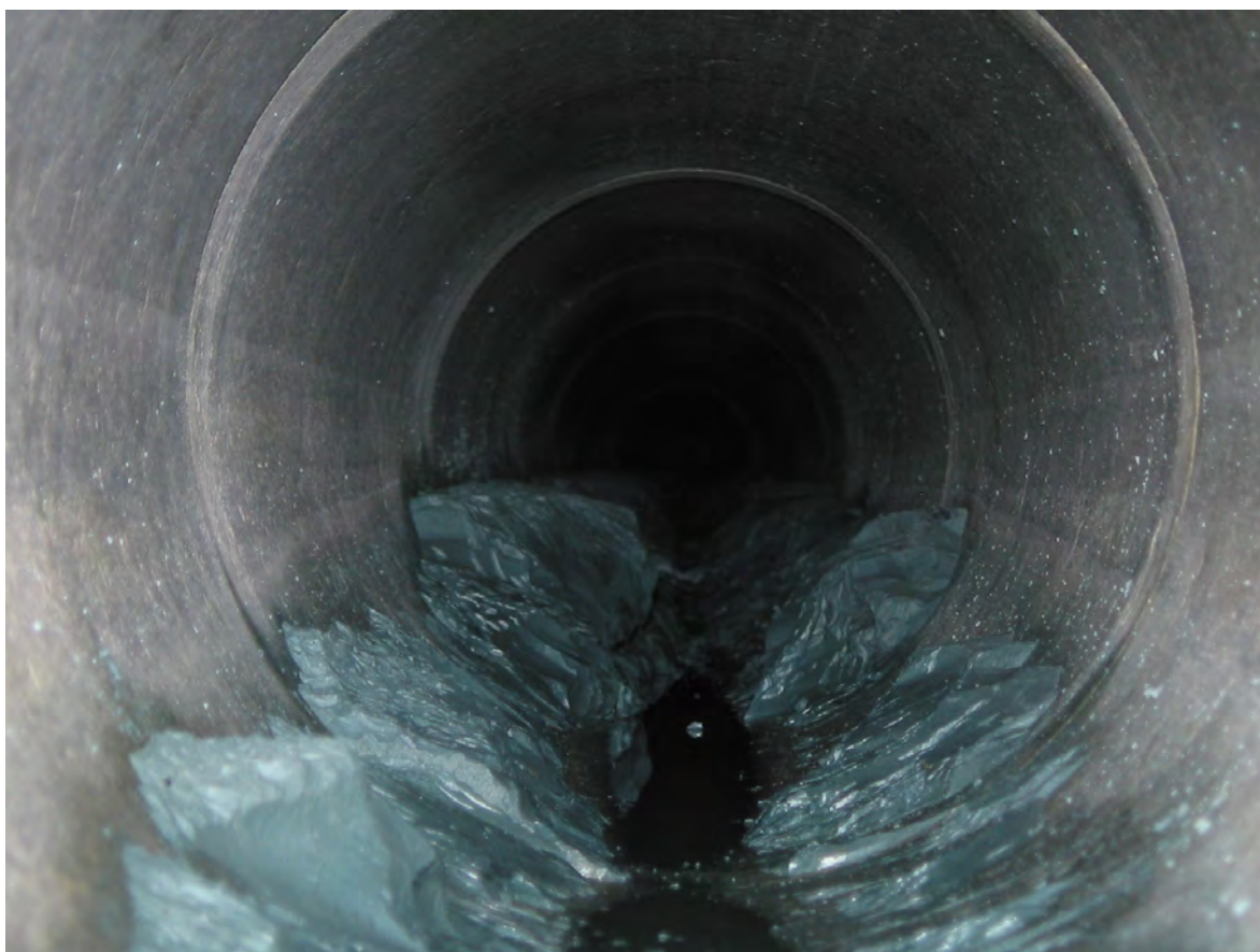
Foto 6 Ledning med fastkittet betonslam
