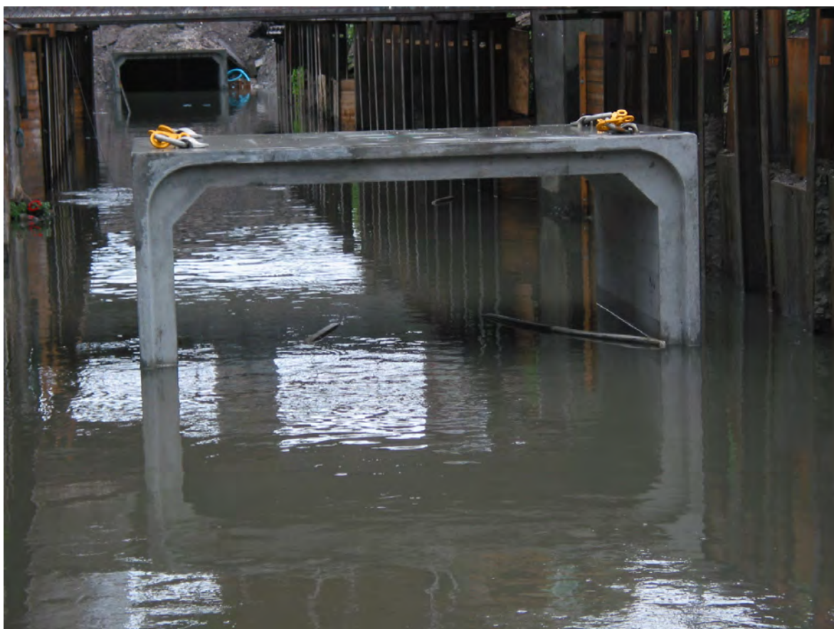
Foto 13 Oversvømmelse af anlægsarbejder på Lersøgrøften
