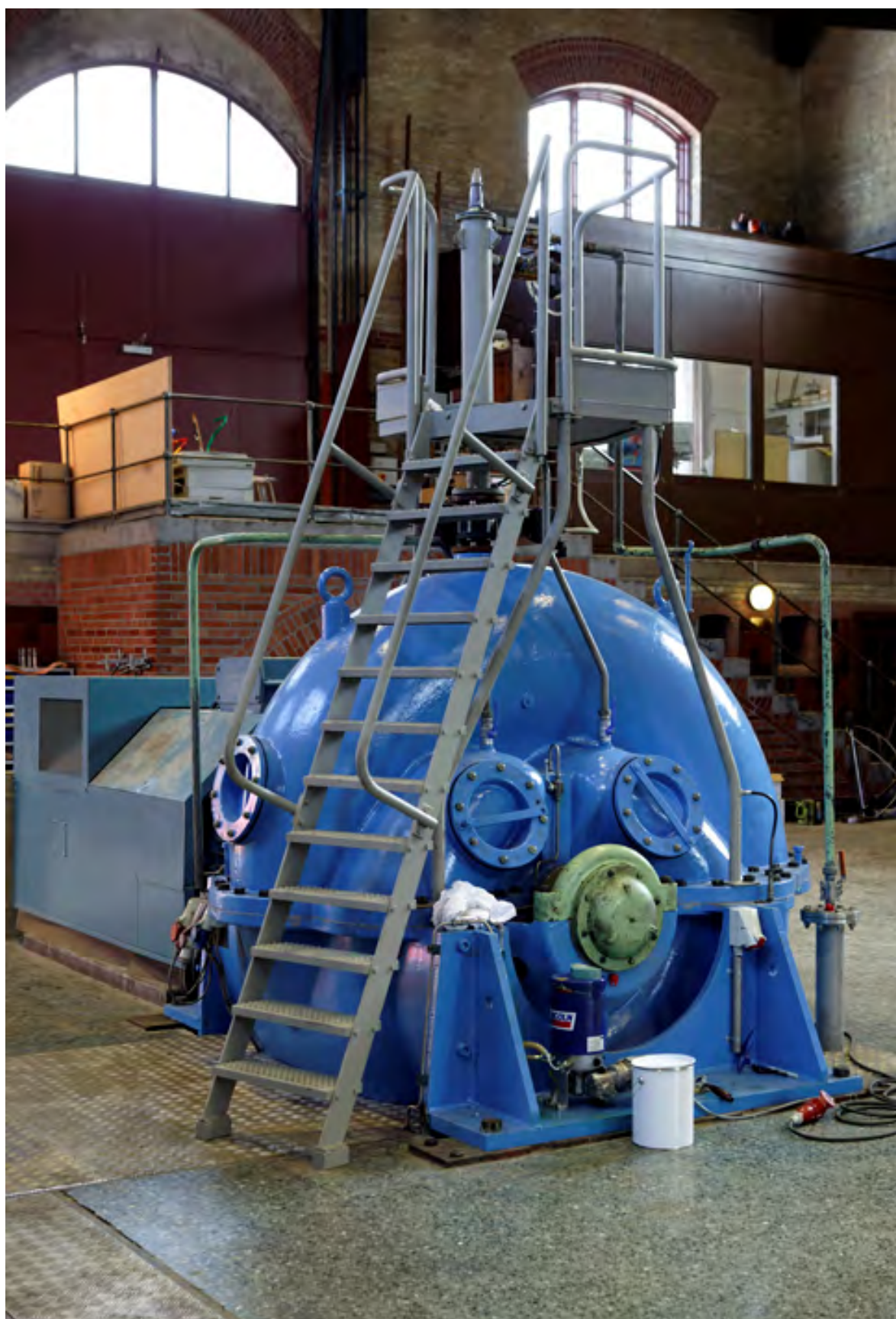
Foto 3 Kløvermarksvej Pumpestation, maskinhallen
