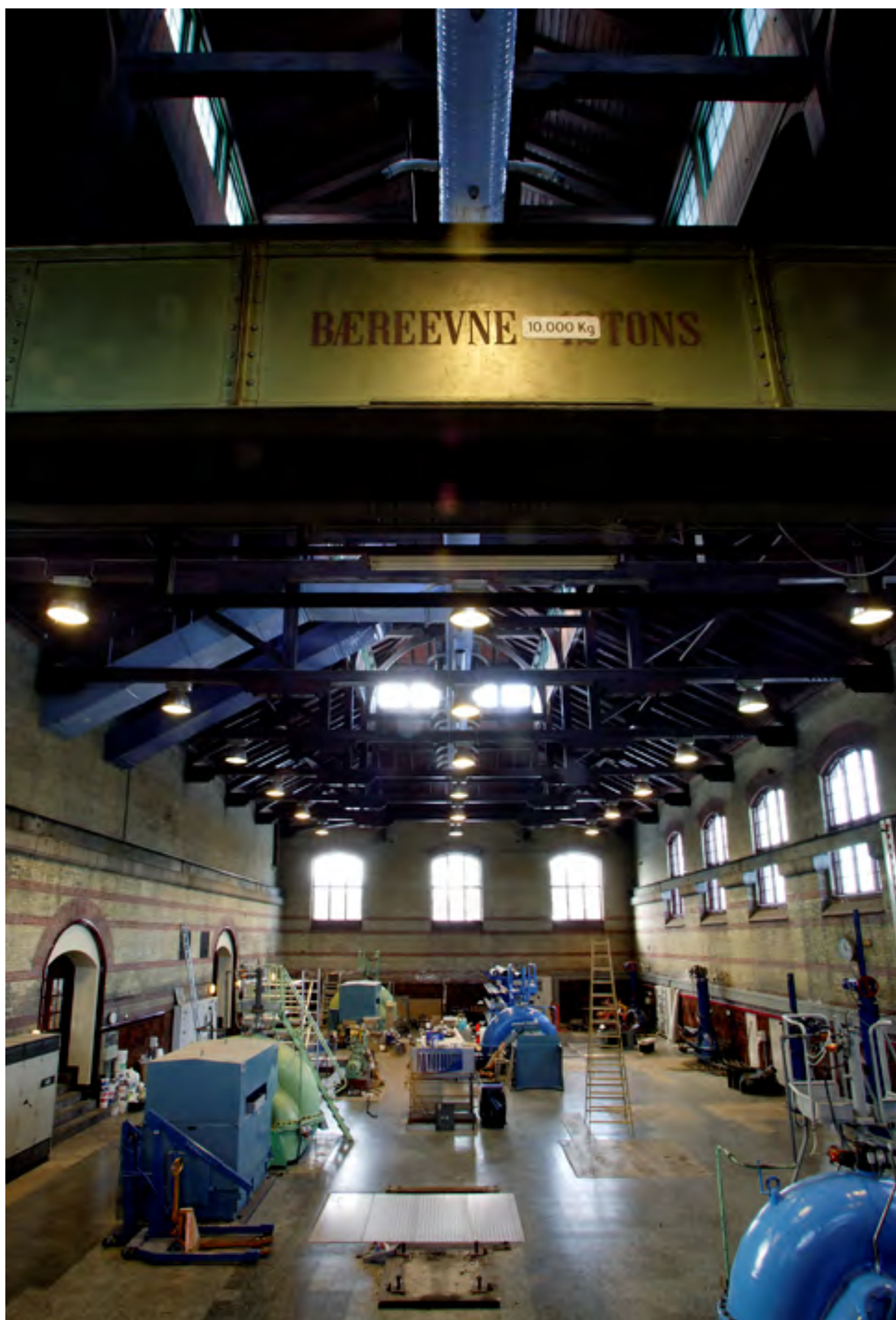
Foto 7 Maskinhallen på Kløvermarksvej Pumpestation
