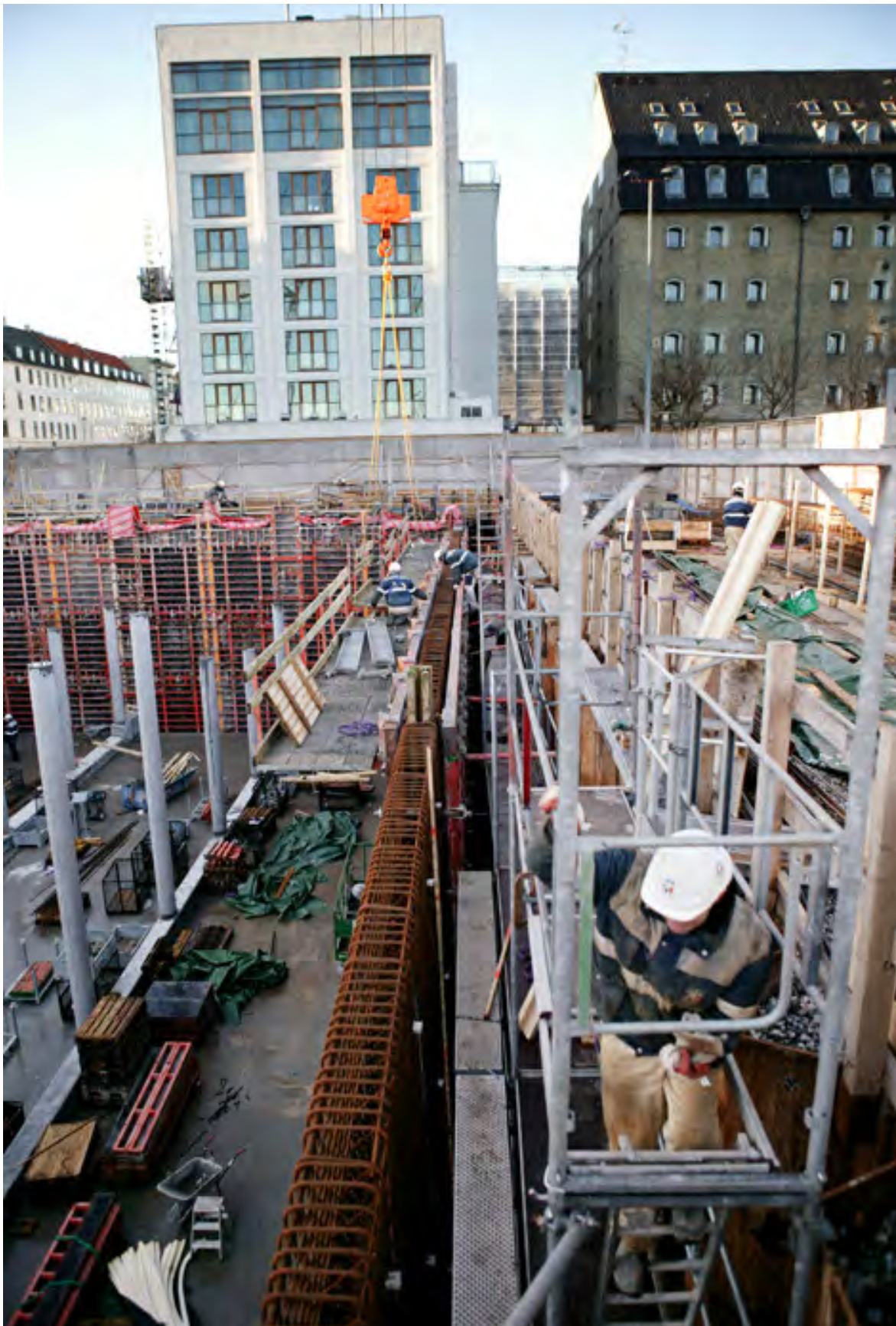
Foto 14 Komplekse anlægsarbejder ved Sankt Annæ Plads
