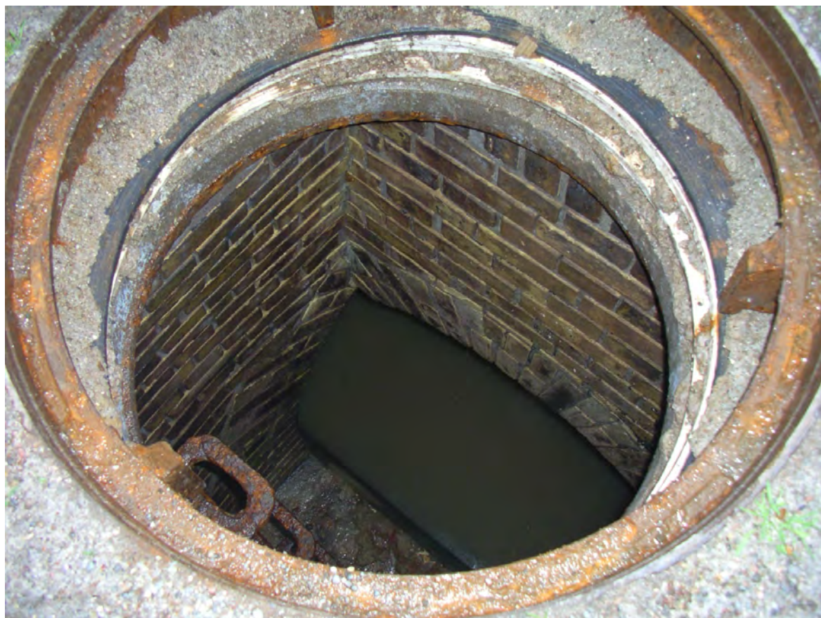
Foto 1 Kig ned i muret brønd
