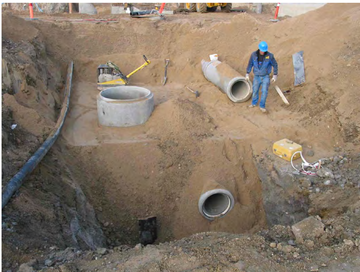
Foto 2 Nykloakering. Der anlægges både spildevandsledning og regnvandsledning
