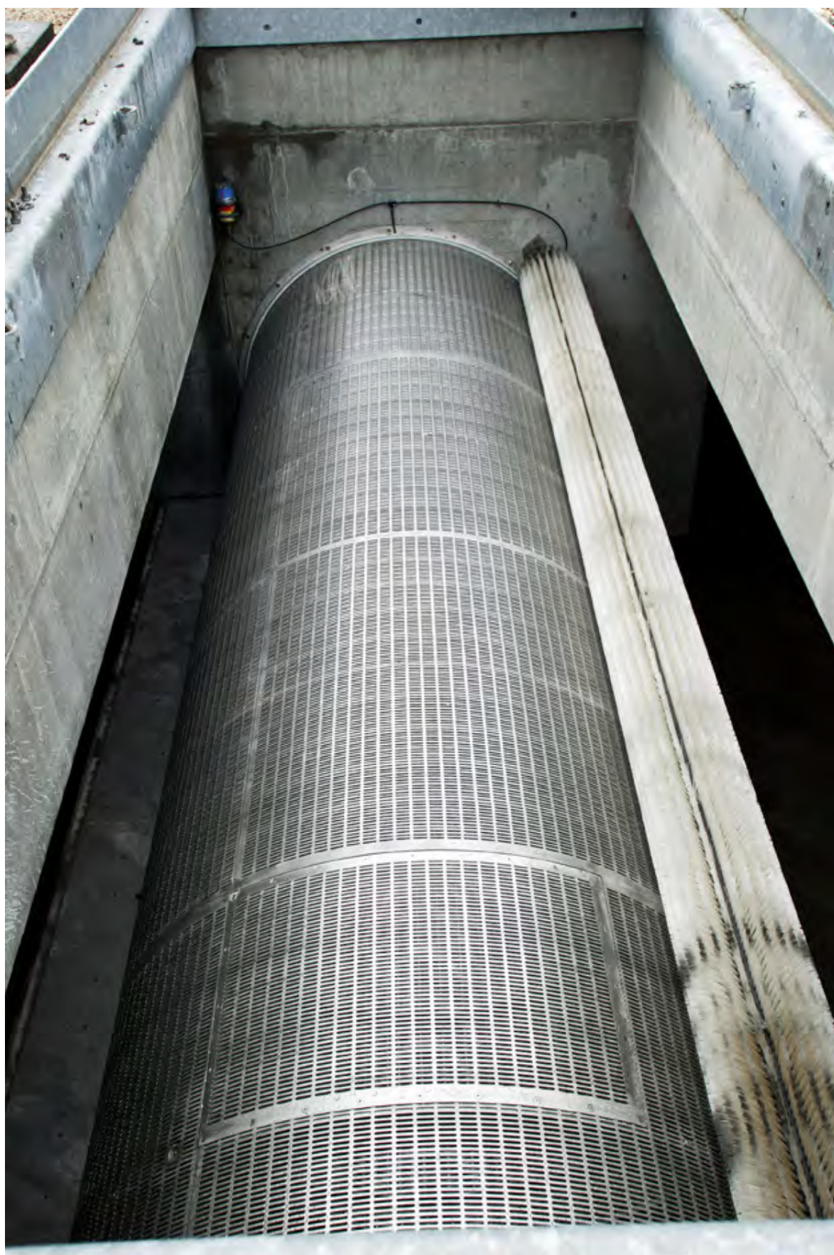
Foto 11 Tromlesi til rensning af overløbsvand inden overløb til Sankt Annæ Plads-bassin
