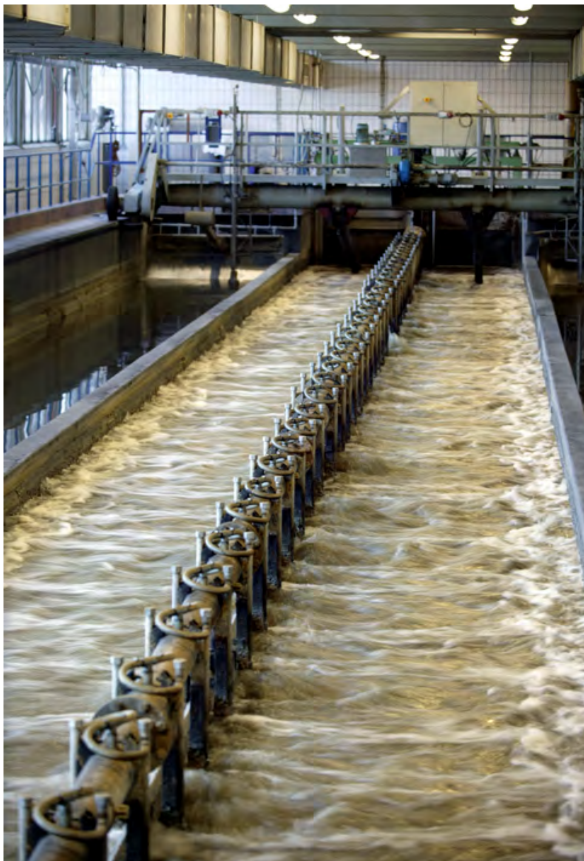
Foto 8 Sandfang på Strandvængets Pumpestation
