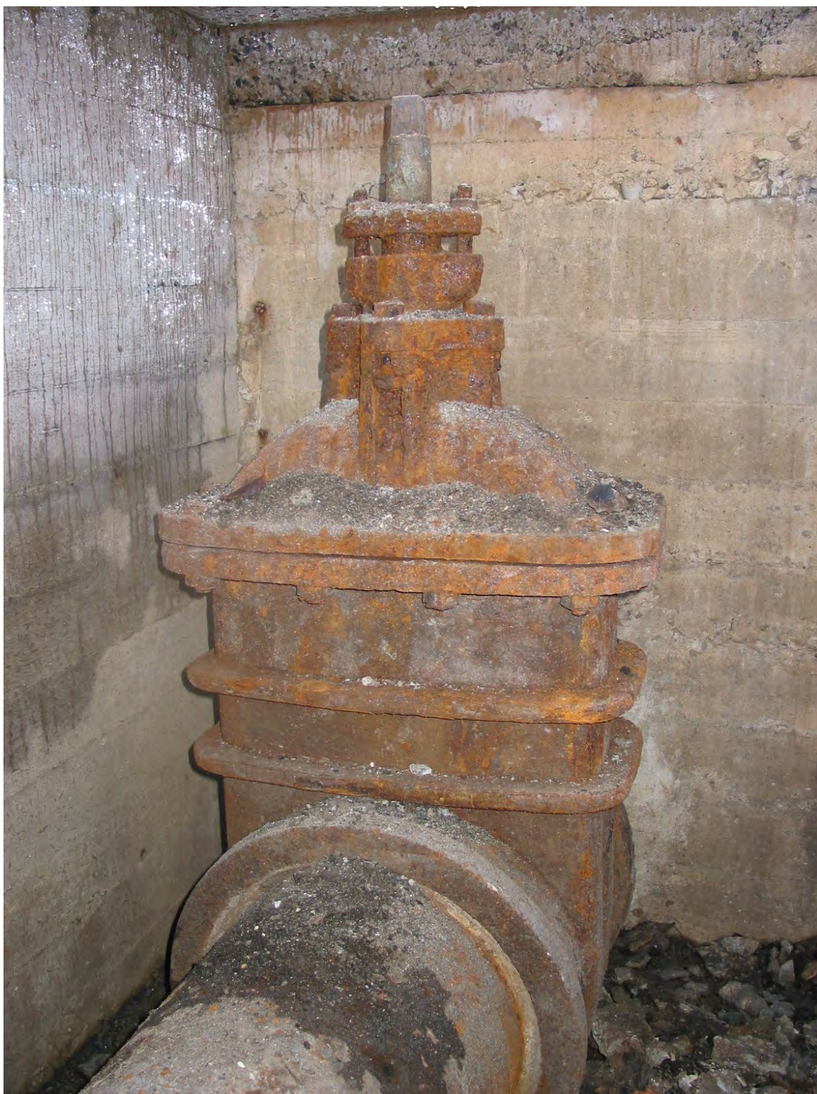
Foto 4 Ventil i bygværk
