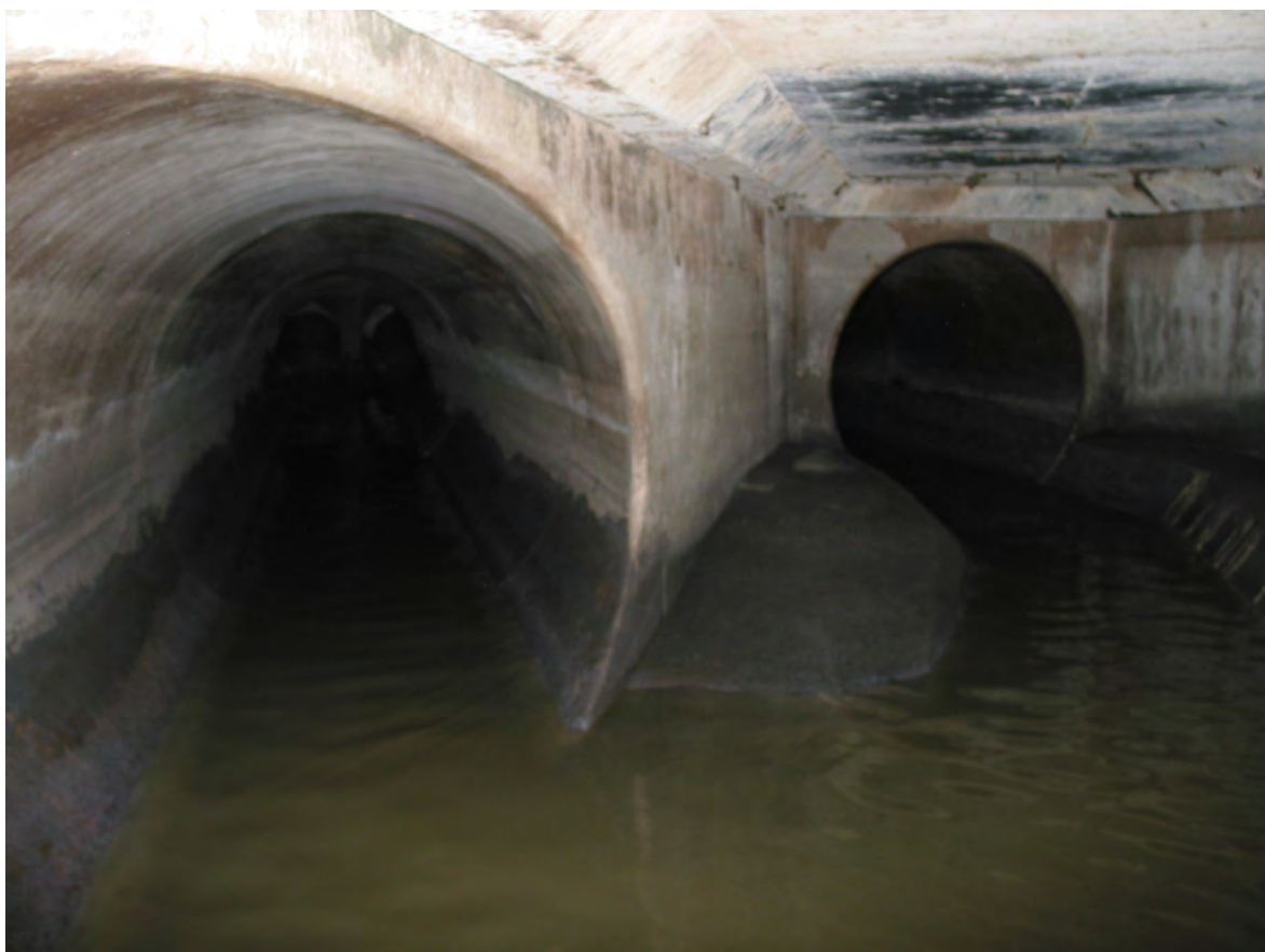
Foto 12 Ledningssammenskæring. To ledninger løber sammen til een
