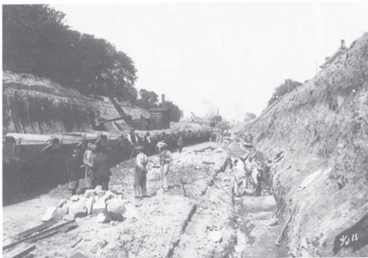
Boulevardbanens udgravning. Anlæggelsen fandt sted i 1912-14, og de bortgravede jordmængder kortes ud i området ved Svanemøllebugten. Billedet viser tipvognstoget, der fyldes af den dampdrevne gravemaskine mellem Nørreport st. og Østerport st. I baggrunden ses spiret på Østerport st. Øverst til venstre ses Østre anlæg. Foto Det kongelige Bibliotek, 1913.
