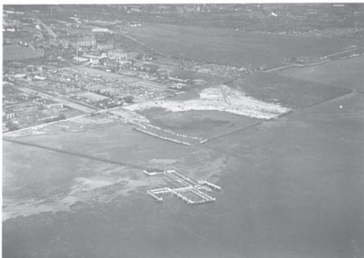
Lossepladsen vokser ud i vådområdet ved Amager Strand. I forgrunden ses badeanstalten Helgoland. På billedet øverst til højre ses endnu sporene efter det gamle søfort Streckers Batteri for enden af Kløvermarken. Foto Det kongelige Bibliotek, 1930'erne.
