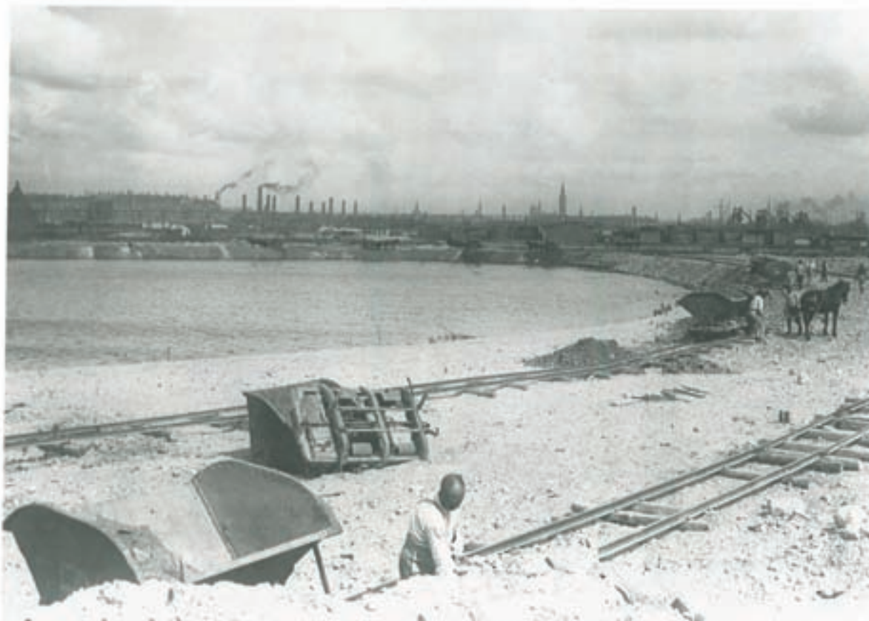
Kalvebod Strand i 1913. Opfyldningen i Sydhavnen er på dette tidspunkt på vej mod området ved Teglholmen og Teglværkshavnen. På billedet ses tipvogne med grus, der tømmes ud i vådområdet. Gruppen af skorstene til venstre i billedet er det tidligere Vestre Gasværk, hvor i dag Den hvide Kødby ligger. Til højre rækker rådhusårnet op over byens tage. Foto Københavns Bymuseum, 1913.
