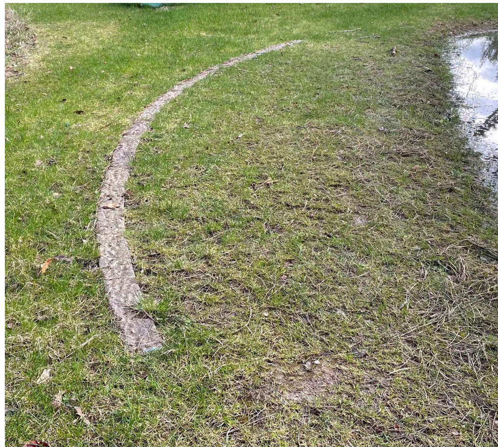
Figur 21 Nødoverløbskant fra Bispebjerg Kirkegård, reference Københavns Kommune
