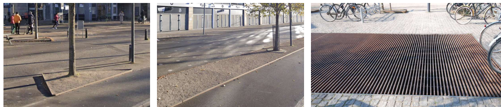
Figur 17 Referencefotos for stålkanter på Øster Allé og udluftningsrist (foto th) på Kgs Nytorv, som tåler tung last.
