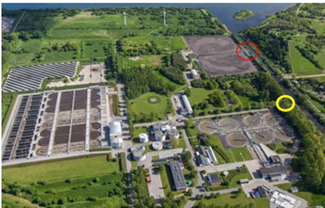
Figur 4.1: Oversigt over Renseanlæg Damhusåen (RD). Til højre ses Harrestrup Å, som har udløb til Kalveboderne. Overløbspunkterne for hhv. renet spildevand og bypassvand fra RD til Harrestrup Å er markeret med en rød og en gul cirkel.
