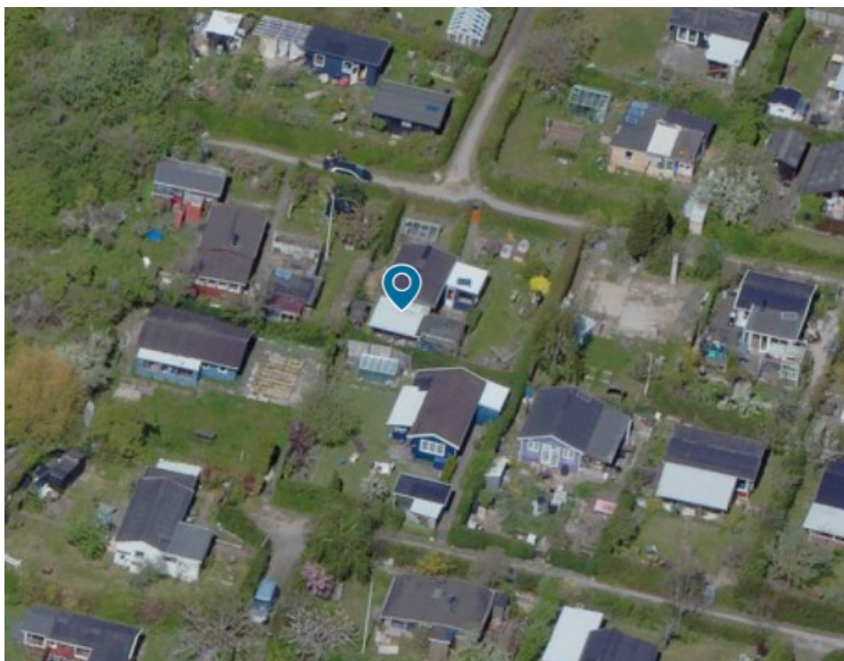
Eksisterende kolonihavehus som nedrives
