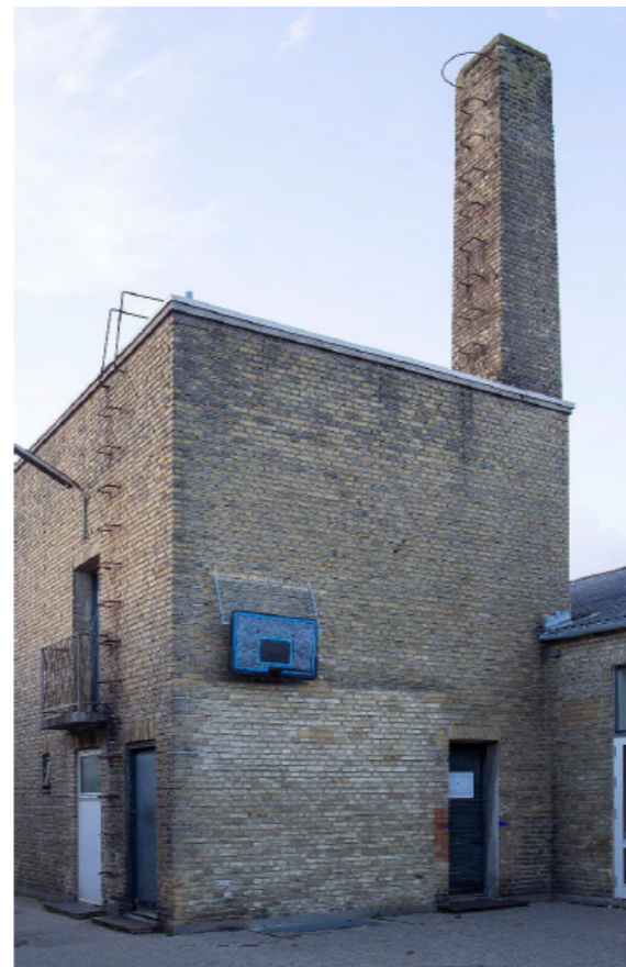
Engvej 143, Kedelhus opført i 1961.
