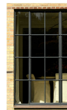
Nye sprossede vinduer i grønblå tone, som fundet i eksisterende malede detaljer samt døre på Skorstenshuset
