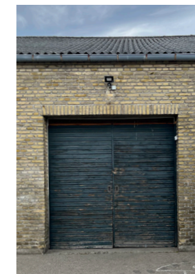
Blågrøn port i træ i facade af gule tegl.
