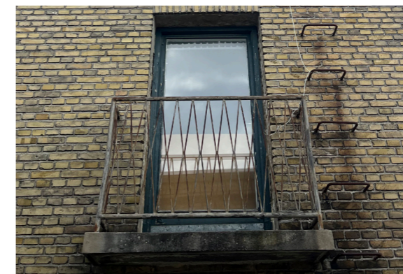
Petroliumsblå dør, gule tegl og detaljer i stål. Spansk altan med vinklede stålbalustre og støbt bund.
