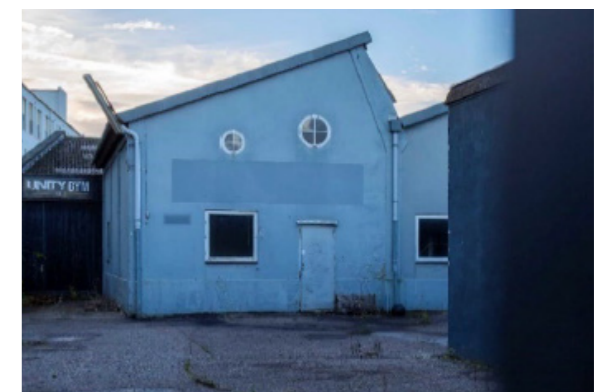
Jorisvej 11, del af fabriksbygning. Opført i 1958. Runde vinduer, pudset mur og shedtag. Motiver genanvendes på udvalgte steder i projektet
