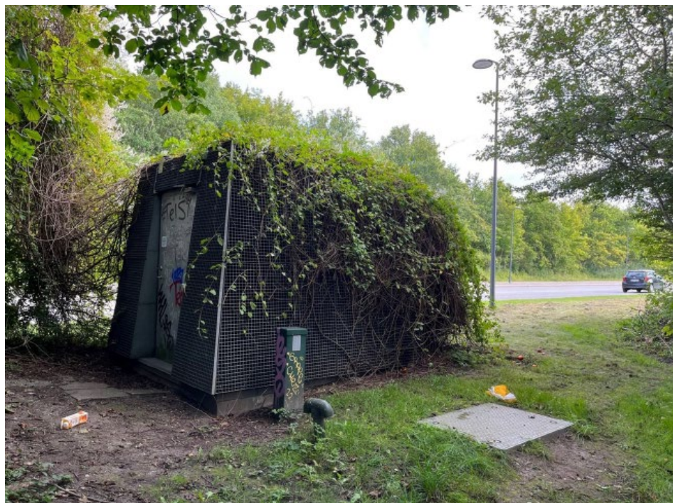
Eksisterende pumpestation som nedrives
