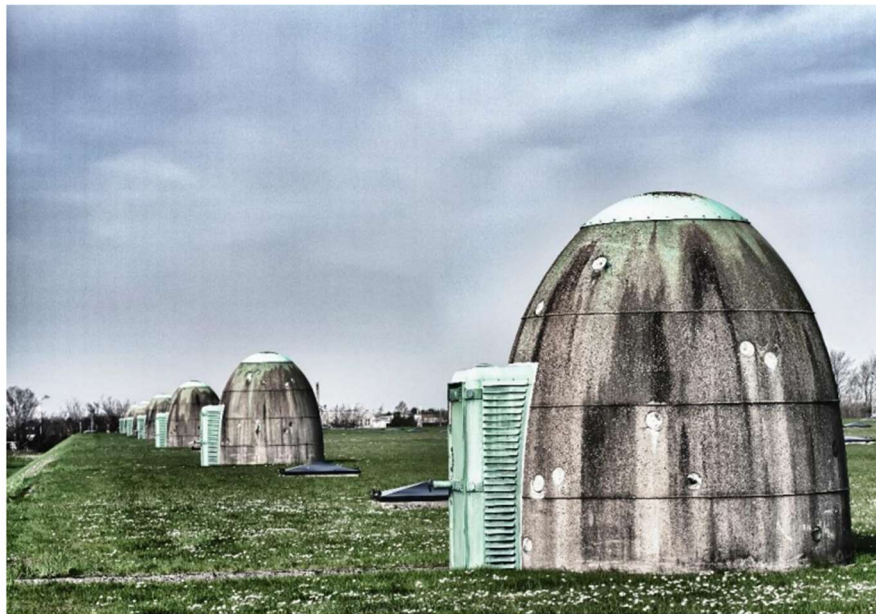
Ved Tinghøj Beholderanlæg
