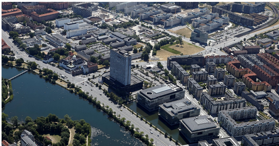
Fig. 6. Lokalplanområdet set fra nord mod syd (fra lokalplan nr. 327, tillæg 4)
