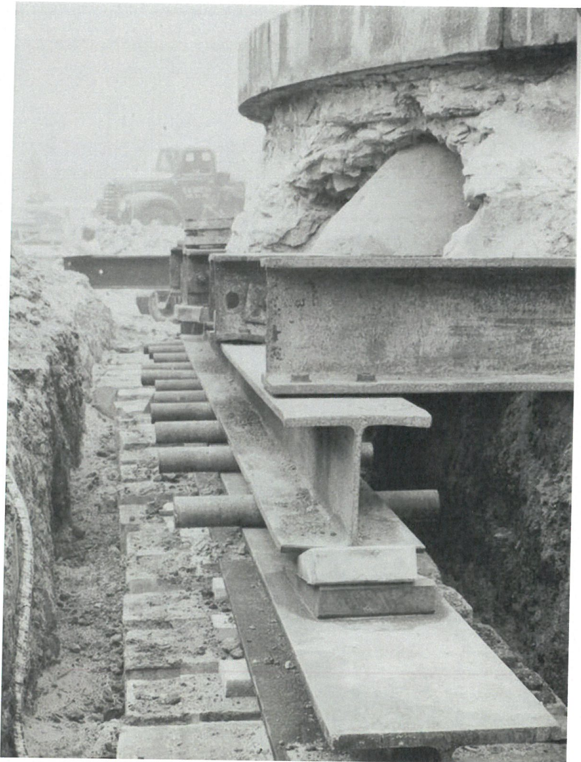
Rådhuspladsen 1954 Flytning af Dragespringvandet foregik ved at frigrave det samlede monument inkl. de omgivende to granittrin. Det blev klodset op på stålprofiler og på stålroller rullet de 25 meter hen til sin nuværende placering. Det ydre bassin blev opmagasineret.
