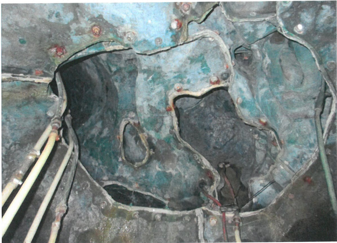
Inde i hovedmonumentet ses, hvordan bronzeelementerne er boltet sammen af mange dele. Stålboltene er rustne på grund af vand, der trænger ind i samlingerne
