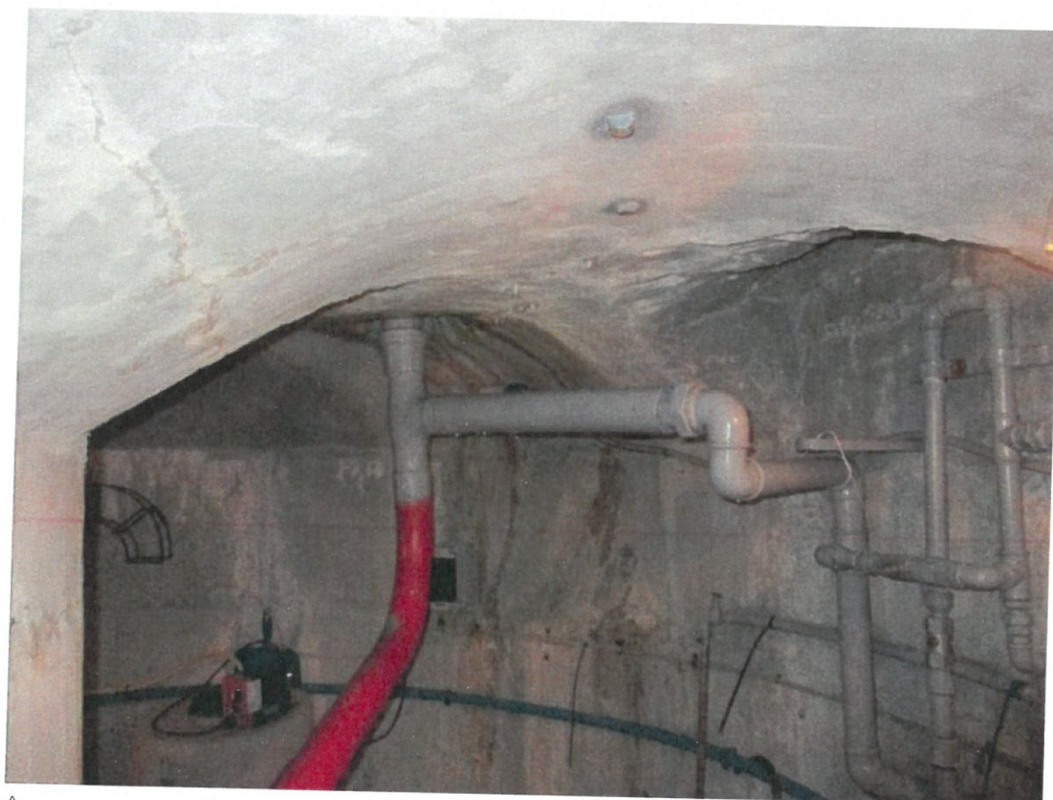
Arbejds- og vandinstallationer i springvandskammeret
