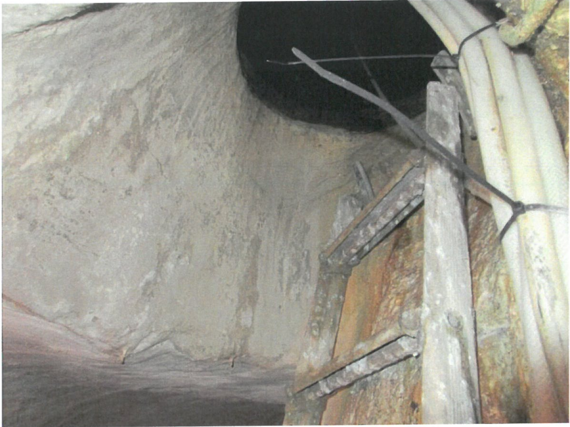
Adgang (stige) og vandforsyning (flexrer) til hovedmonumentet fra springvandskammeret
