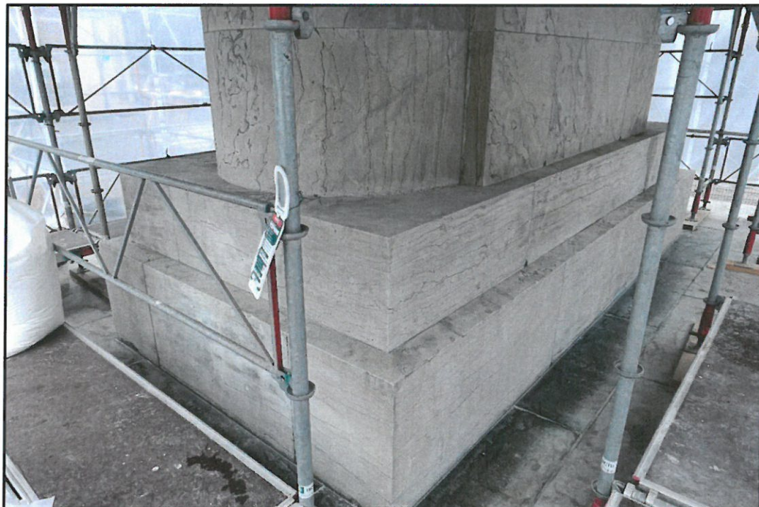
Foto 25: Nedre del af sokkel, nordside efter behandling.
