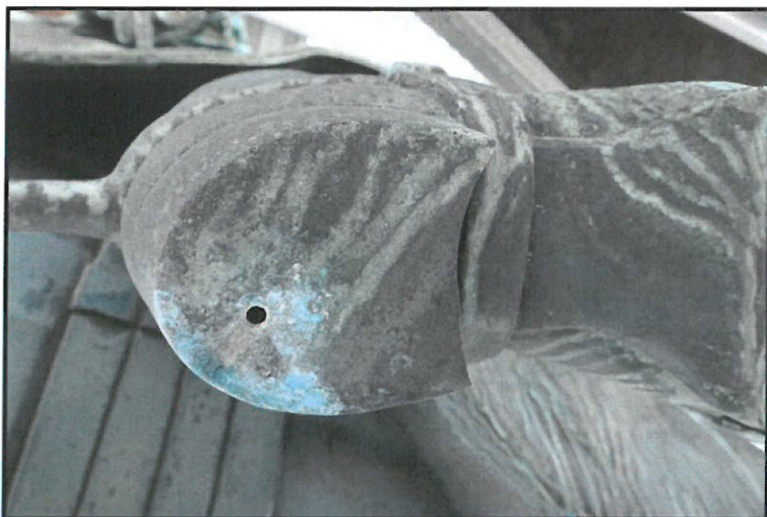
Foto 7: Blålig udfældning, der skyldes udvaskning af kobbersalte fra skulpturens indre, formentligt blandet med rester af støbemateriale.
