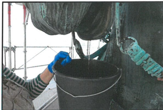
Foto 15: Opsamling af kondensvand efter boring af drænhul.
