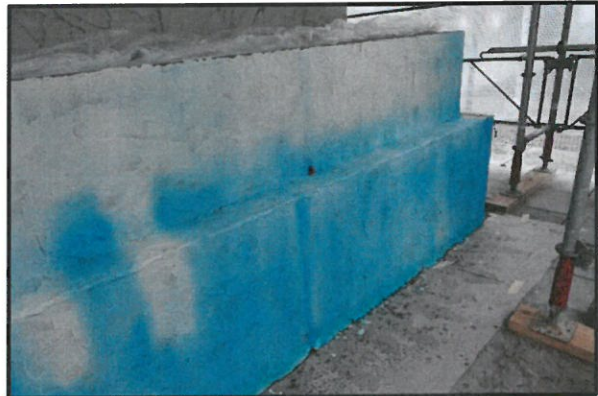
Foto 21: Afrensning af kobbermisfarvninger med ammoniumcarbonat.
