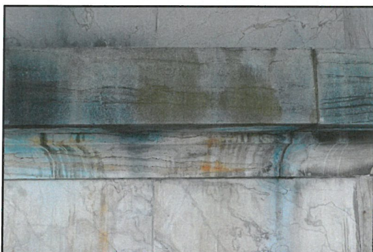
Foto 17: Organisk begroning, kobbermisfarvninger og rustudfældninger fra iboende jernholdige mineraler
