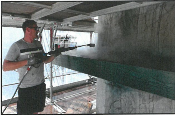
Foto 20: Hedvandsrensning ved lavt tryk og høj temperatur.
