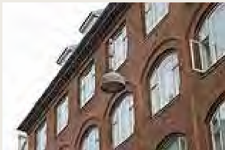
Københavnerarmaturet ophængt i wire bruges som gadebelysning over det meste af byen
