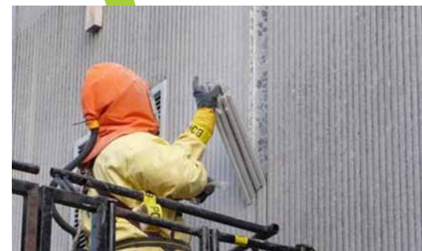
RENSNING AF BYGNING INDEN NEDRIVNING
