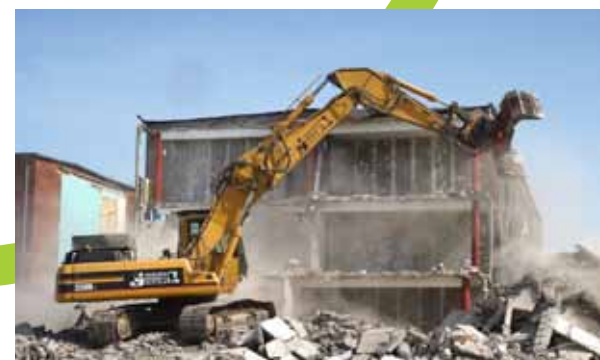
NEDRIVNING AF BYGNING
