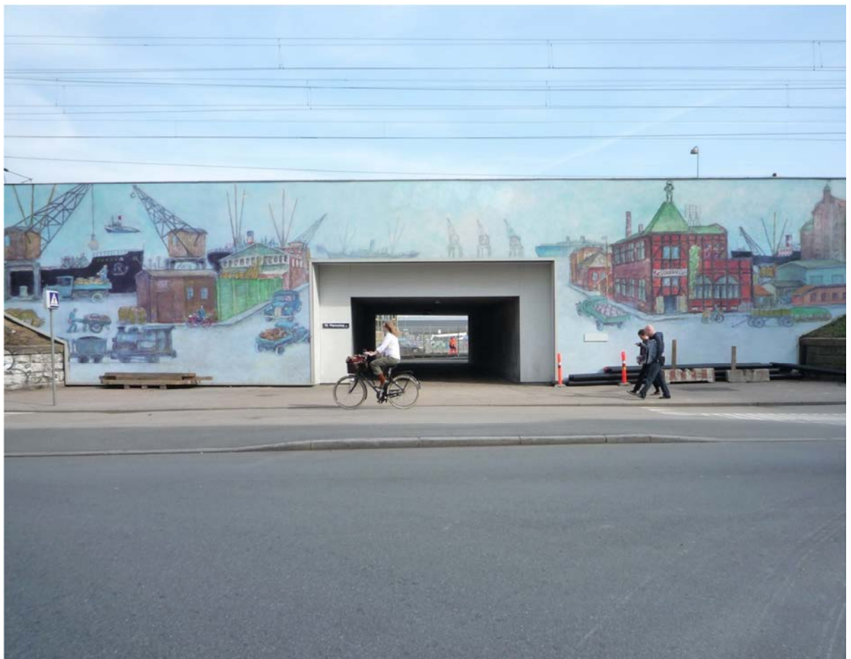
Figur 6-21 Foto af tunnel ved Nordhavnsstation.
