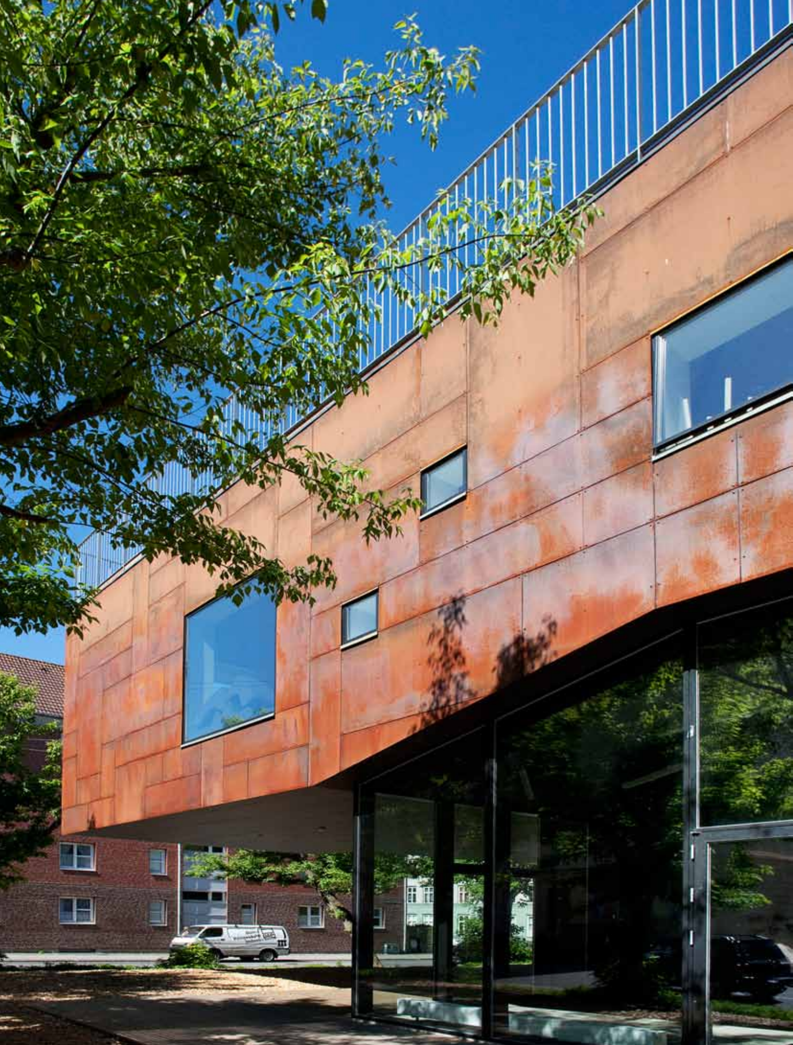
Fritidshjemmet Universet i Meinungsgade har flere energirigtige tiltag: Stor udnyttelse af dagslys, energieffektiv belysning og 42m 2 solceller/ Foto af Anders Viid
