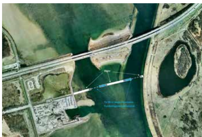
Figur 7: Etablering af sikringsanlæg syd for Kalveboderne.
