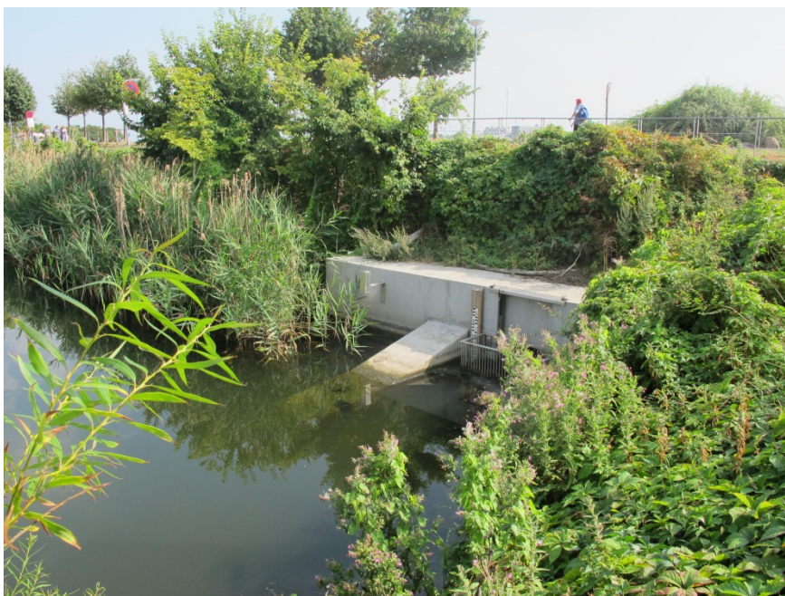
Figur 24 Afløbsbygværket fra Kastelsgraven til Øresund
