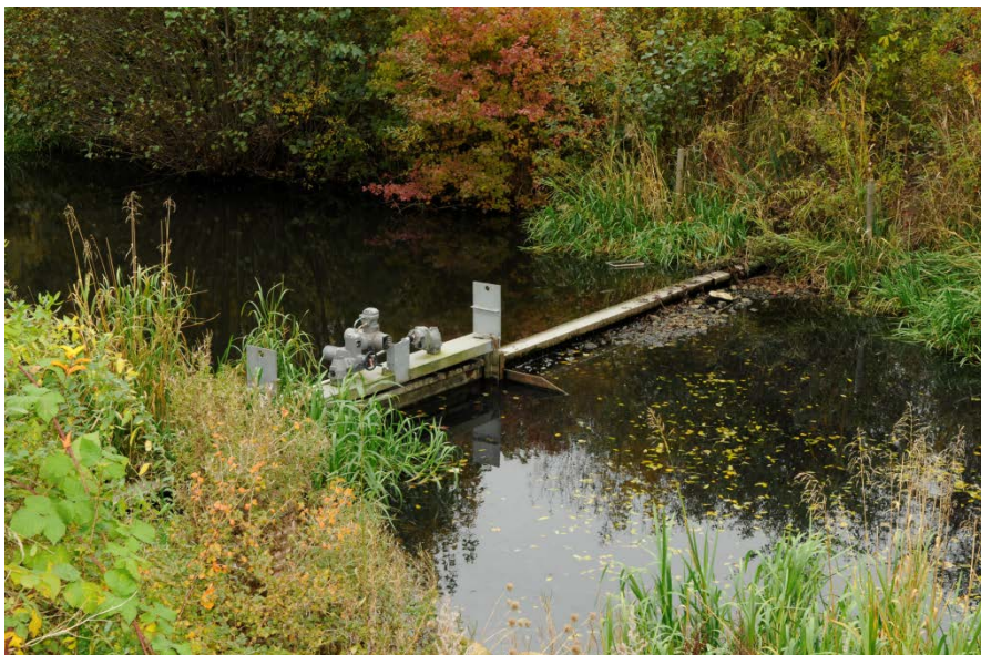
Figur 10 Stemmeværket ved Dunhammervej. Den venstre del er det styrbare stemmeværk, og højre del er den faste overløbskant i kote 16,92 m DVR90.
