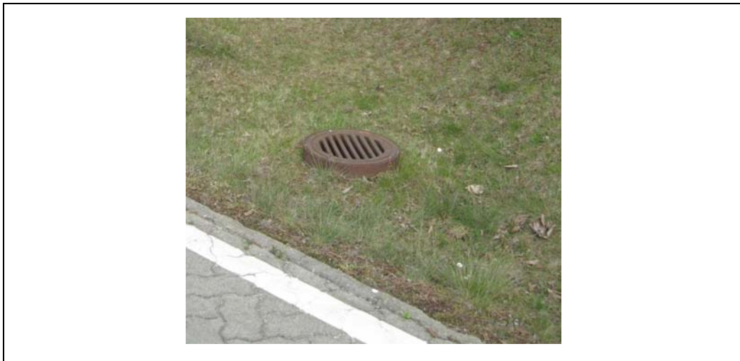
Figur 3.2 Eksempel på vejbrønd i græsplæne
