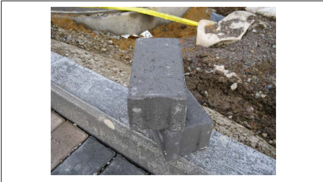
Figur 3.3 Belægningssten med reces til porøs fuge
