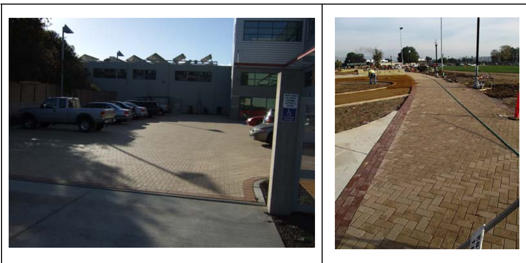
Figur 3.5 Parkeringsareal og sti med permeable belægningssten
