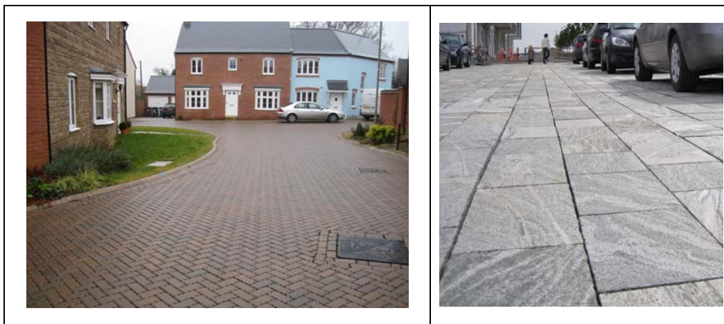
Figur 2.2 Belægningssten med porøse fuger, Banbury UK og eksempel fra Ørestad med granitsten med brede fuger
