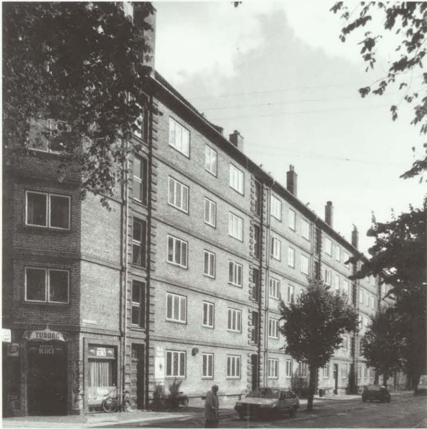
Arkitekt Poul Baumann har tegnet karréen på hjørnet af Bavnehøj Allé og Enghavevej. Den nyklassicistiske bygning, der er opført i 1929, har træk påvirket af den begyndende funktionalisme, her især vinduesformaternes
