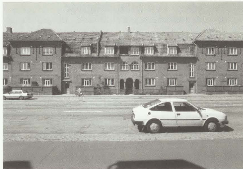
Bebyggelse på nordsiden af P. Knudsens Gade. Desværre er der her foretaget en del uheldige vinduesudskiftninger, ligesom der er isat vinduer i enkelte loggiaer.
