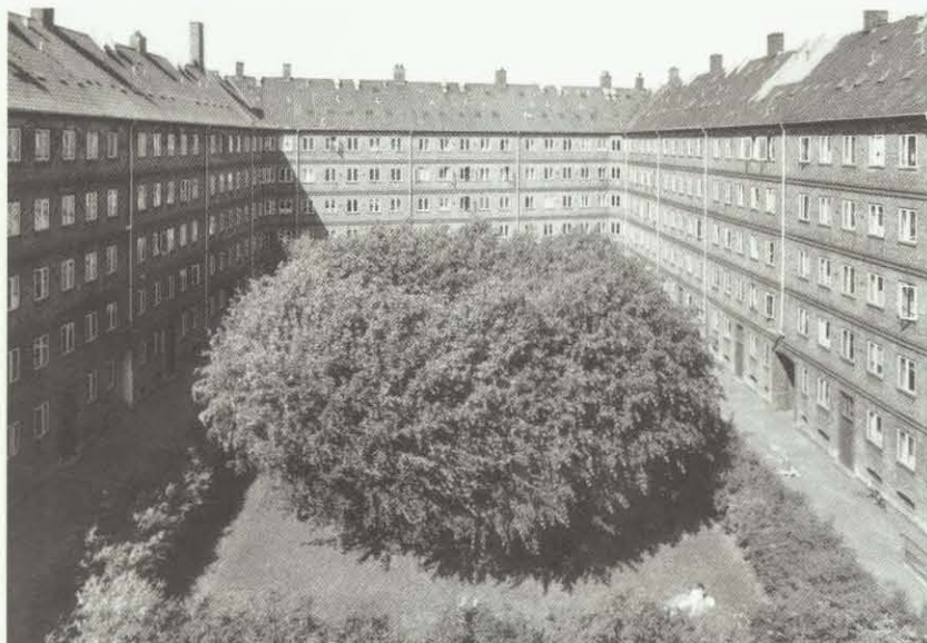
Gårdrum i karréen Bavnehøj Allé/Johan Kellers Vej/Hans Olriks Vej/Enghavevej, set mod nord (1).
