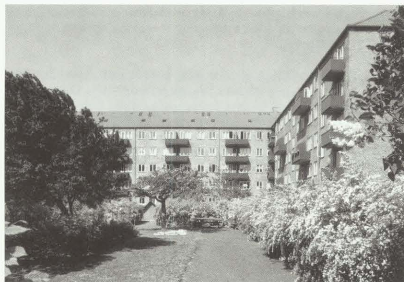
Gårdrum i karréen Edvard Storms Vej/Johan Kellers Vej/Tranehavevej/Enghavevej, set mod nord (2).
