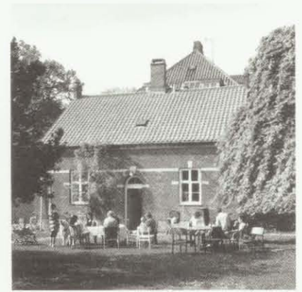
Fritliggende længe til den oprindelige hovedbygning fra 1880. Til forskel fra hovedbygningen, der har skifertag, er denne bygning med tegltag. Flere af længens bygningsdetaljer svarer til hovedbygningens, bl.a. skorstensudformningen.
