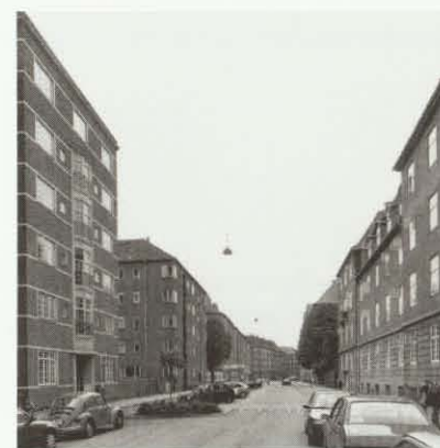
Fensmarksgade set mod sydvest. Vejenes bløde kurver skaber lukkede gaderum. Træerne markerer en sidegade, og skaber et grønt indslag i gadebilledet.
