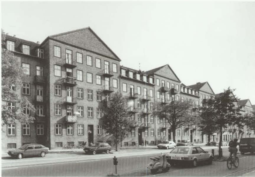
Boligbebyggelsen Haraldsgade 18-42 blev opført i 1934. Den 4½ etages bygning er i gule mursten og med tegl på taget. Den lange facade brydes af fem etager høje, fremskudte partier. Balkoner med spinkle originale jernrækværk pryder facaden, der er uden dekoration. En nyklassicistisk bebyggelse bygget i overgangen til funktionalismen.
