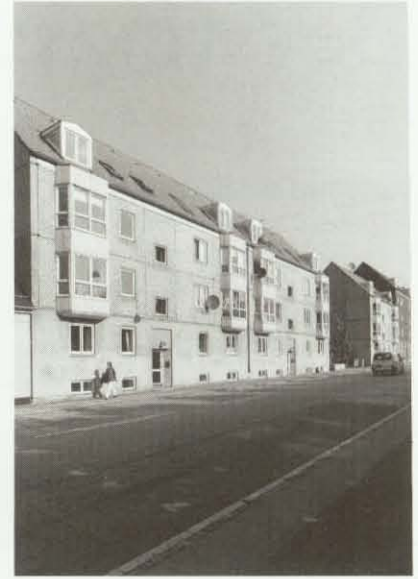
Stengades nye bebyggelse har et udtryk, der er meget forskelligt fra Nørrebro's øvrige, ældre etagebebyggelse. Både proportioner, materialer og detaljering afviger stærkt fra det, der før var kendetegnende for brokvarteret.
