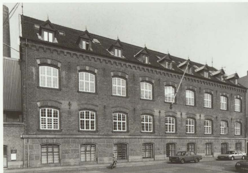
Brødrene Cloettas Chokoladefabrik, Hørsholmsgade 20 blev bygget i 1901 med professor Ludvig Knudsen som arkitekt. Den gedigne industribygning er opført i kvadergranit og røde håndstrøgne sten, i stik og gesims er anvendt Ølandsten og kridtsten, og taget er dækket med glaseret tegl. Bygningen, der er rytmisk opbygget med adgang i gavlen, er et smukt og velbevaret eksempel på industribyggeri.
