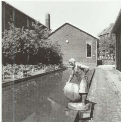
Københavns Maskinmesterskole. Haveanlægget er indrettet til ophold. Mod Lersø Parkallé fremstår bygningen med markante tagflader.
