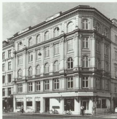
Hjørneejendommen Fælledvej 27, der er opført i 1884 af snedkermester Christian Dahl, er i fem etager samt udnyttet mansardetage. Facaden er pudset og rigt dekoreret med søjler, vinduesindfatninger, friser og en kraftig gesims. Den historicistisk inspirerede bygning indgår smukt i gadebilledet, men skæmmes af butiksfacaderne, der ikke harmonerer med bygningen.
