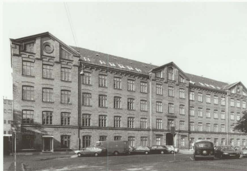
Aktieselskabet Glud & Marstrands Fabriker byggede efter arkitekt A.O. Lefflands tegninger den gedigne fabriksbygning Struenseegade 7. Bygningen er opført i 3 1/2 etage i røde mursten og med skifer på taget. Facaden er symmetrisk opbygget med midt- og siderisalitter. Et bånd markerer overgangen mellem den høje kælder og stueetagen. Vinduesstikkene er markeret med en spinkel takfrise, og gesims og risalitter er udformet i mønstermurværk. En helstøbt og solid industribygning.
