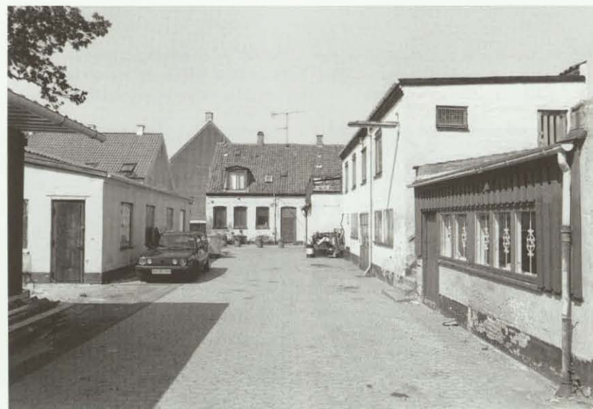
Rådmandsgade 30, set mod nordvest. Erhvervsbygningerne har en købstadsagtig karakter.
