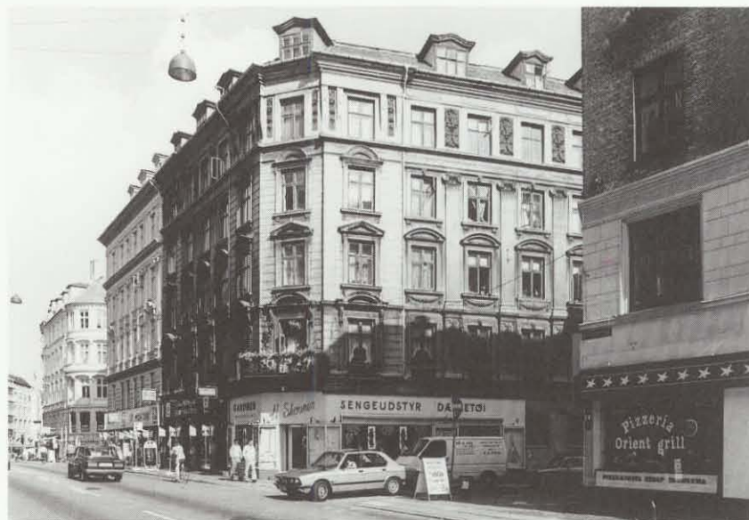
Valdemarsgade 1 er bygget 1875 og forsynet med et utal af dekorative elementer: refendfugning, relieffelter, pilastre og fordakninger.
