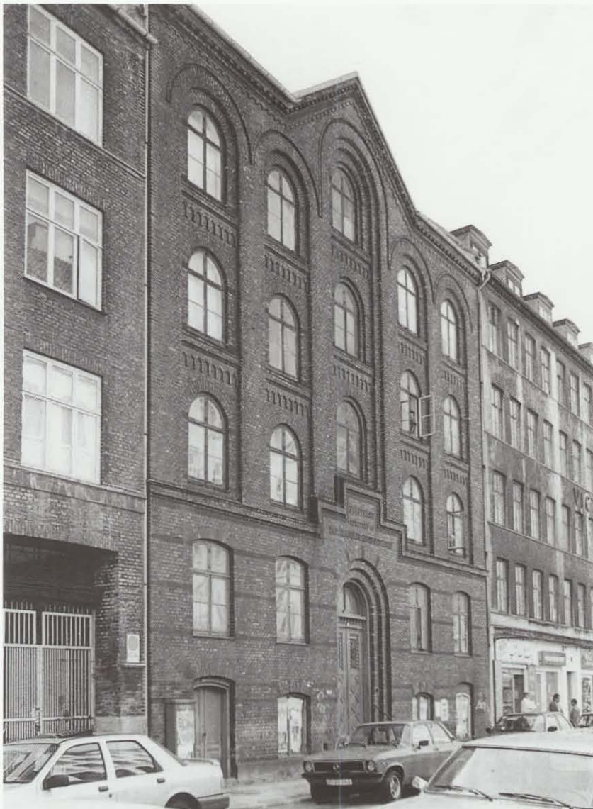
Stiftelse, Viktoriagade 20, opført 1855 af J.C. Sørensen. Den stærke lodrette opdeling af facaden giver mulighed for at hæve hovedtrappens reposvinduer over de øvrige.
