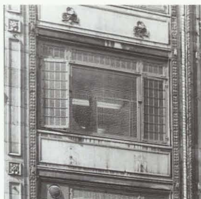
Facadedetalje fra Vesterbrogade 34
