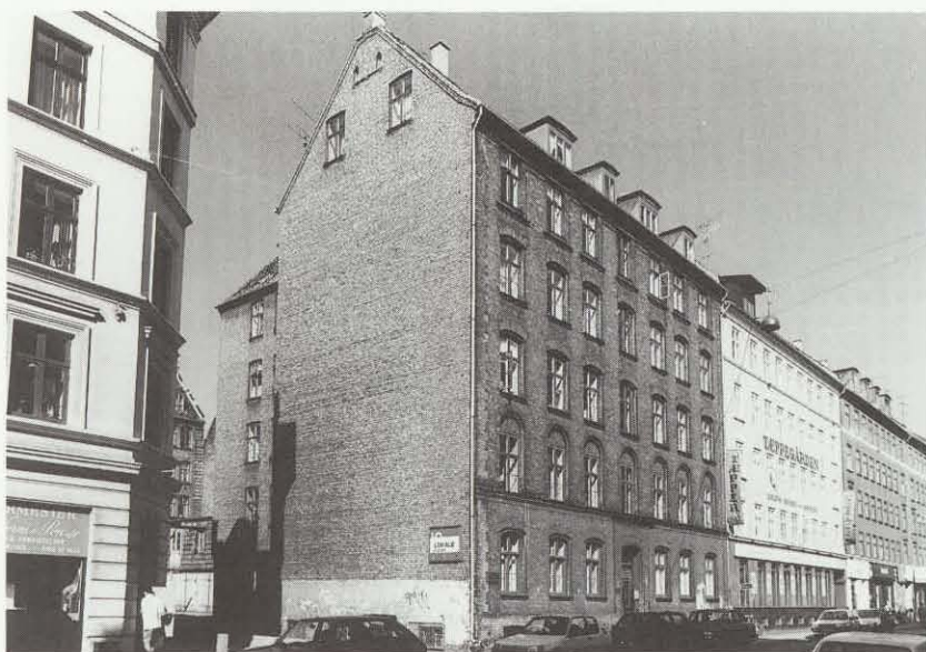
Gasværksvej 10 fra 1868 har en levende facade, hvor der er anvendt mange forskellige formsten.
