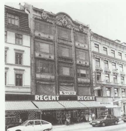
Vesterbrogade 34 af arkitekten Anton Rosen er opført i 1907. Facadens dekoration understreger det 'ikke bærende' i konstruktionen. Bygningen er fredet.
