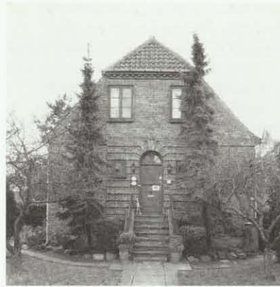
Bedre Byggeskik-inspirationen præger en stor del af villabyggeriet i mellemkrigstiden. Vejlands Allé 101, opført 1929, har en smuk, symmetrisk gavl med mange fint gennemarbejdede detaljer.
