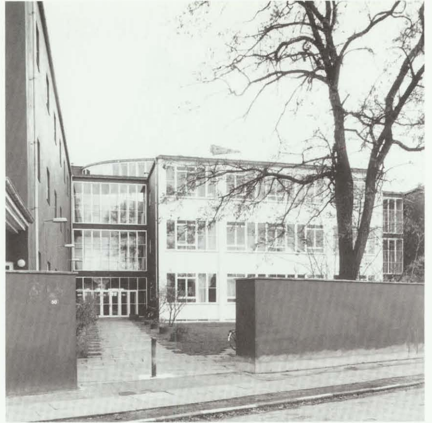
Skolen ved Sundet på Samosvej er sammen med Friluftsskolen samme sted opført i 1937 med Kaj Gottlob som arkitekt. Begge skoler er fredede. Skolen er et karakteristisk eksempel på funktionalismen fra 30'erne, præget af gennemgående vinduesbånd, flade tage og lyse farver.
