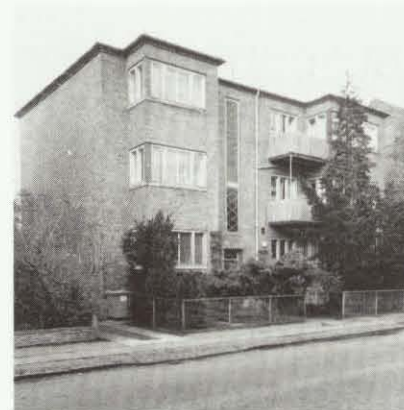
Amsterdamvej 15 er et funktispræget etagehus. Bygningen er opført 1936. Både hjørnevinduerne og det gennemgående vinduesparti ved trappen er karakteristiske, funktionalistiske træk.
