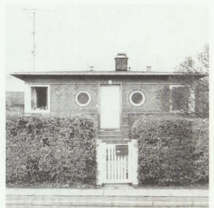
Borneovej 21 er opført i 1934. Den funkisprægede bungalow har et flot indgangsparti, flankeret af runde vinduer. Bemærk bygningens vandrette, murede bånd.
