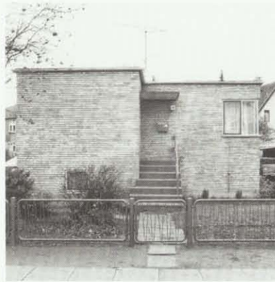
Kirsten Kimers Vej 18, der er opført 1935, er et typisk funkishus med hjørnevinduer og baldakin ved hoveddøren.
