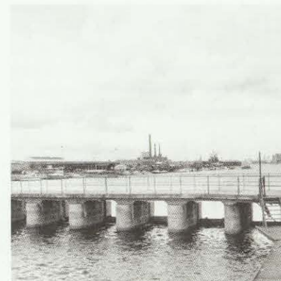
Sluseanlægget, set mod nord
