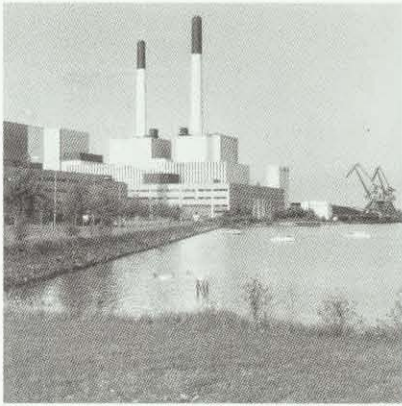
Amagerværket set mod nordøst
