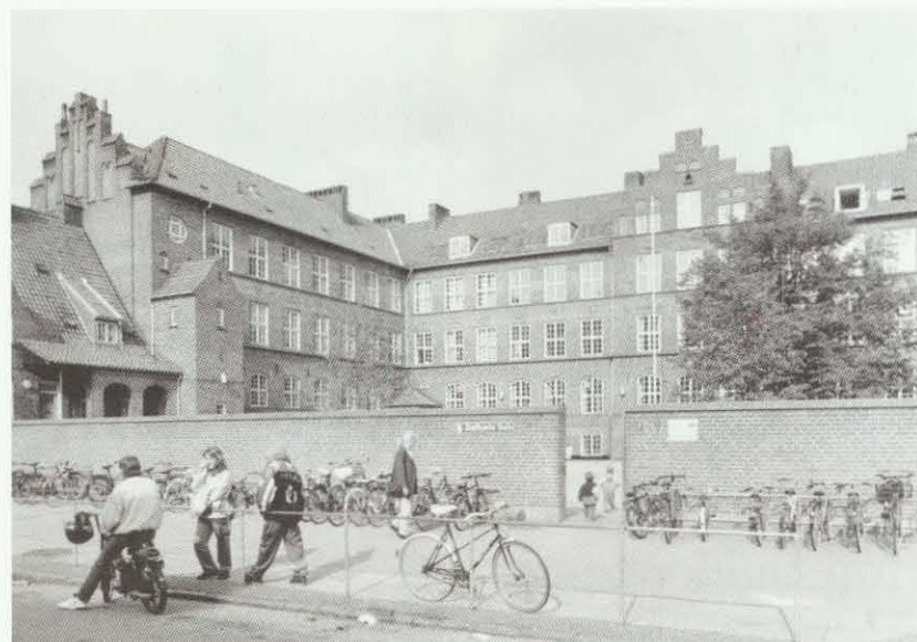
Sundby Øster Skole, set mod nordvest
