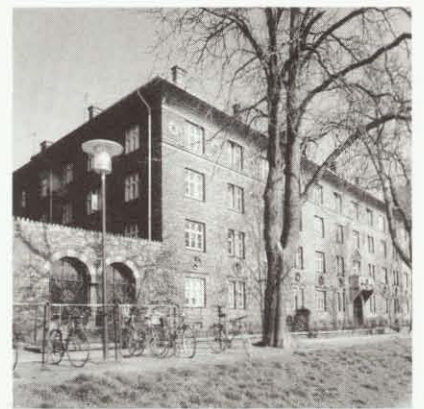
Den Soldenfeldtske Stiftelse, Ryesgade 104, er opført 1895 og tegnet af professor, arkitekt H. Storck. Bygningens indgangsparti er markeret med altan, og facaden er udsmykket med terrakottarosetter
