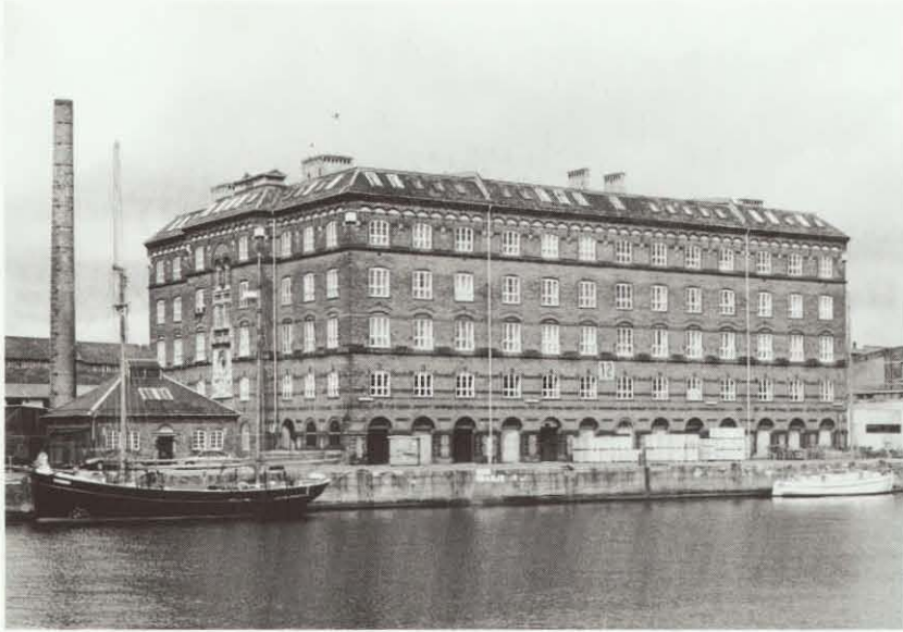
Silopakhus B er opført i 1903 ved arkitekt F.L. Levy og ingeniør C. Agerskov for Københavns Frihavn A/S. Bygningen er opført med den nederste etage i røde sten og en silosektion af profilerede betonskærme. Taget er helvalmet og har en gennemløbende lanterne i rygningen. De flankerende gavltårne har spidstage, beklædt med skifer. Bygningen er meget markant i bybilledet, og kan ses fra mange steder på Østerbro.
