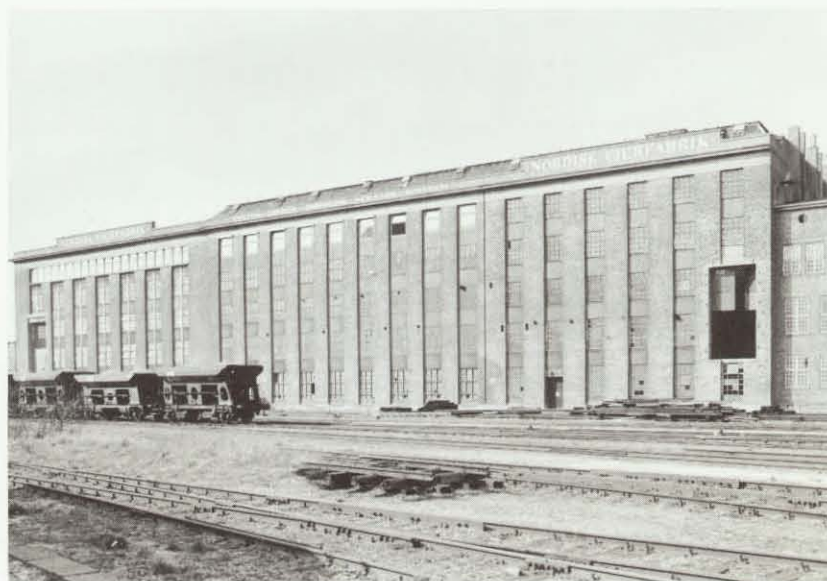
Nordisk Fjerfabrik, Gittervej 6 er opført 1931 med Victor Nyeboelle som arkitekt. Det er et stramt opbygget industri anlæg, der udgør et markant indslag i Østerbros bybillede - både set fra toget og fra Østbanegade.
