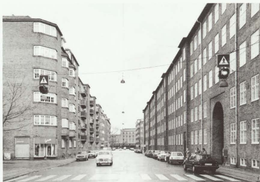
Porten til Classens Have. Nordisk Fjer's store bygning afslutter vejrummet
