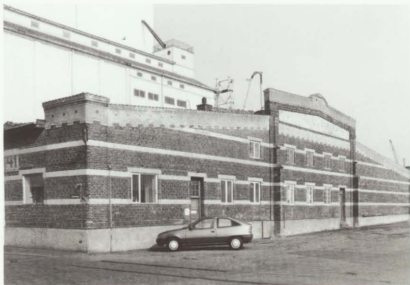
Forbindelsesvej 5 i Sønder Frihavn, der er opført 1917, rummede oprindeligt funktionærboliger og provianteringsboder. Arkitekterne E. Schiødt og Chr. Jensen har udformet huset med røde sten og granitsokkel. Bygningen er inspireret af engelsk arkitektur, og især proviantbygningerne har en spændende facade.
