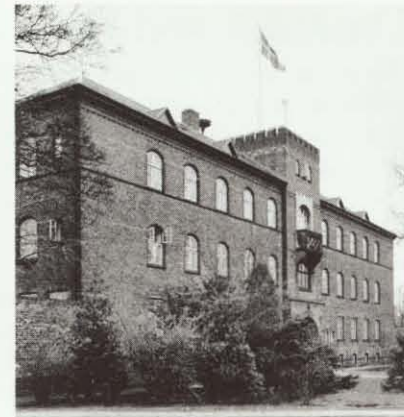
Hovedbygning, set mod nord
