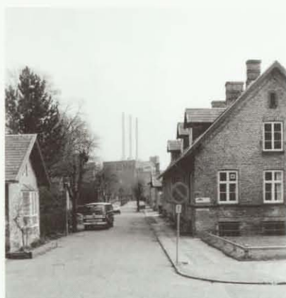
Hospitalets hovedgade med Svanemølleværket i baggrunden, set mod øst
