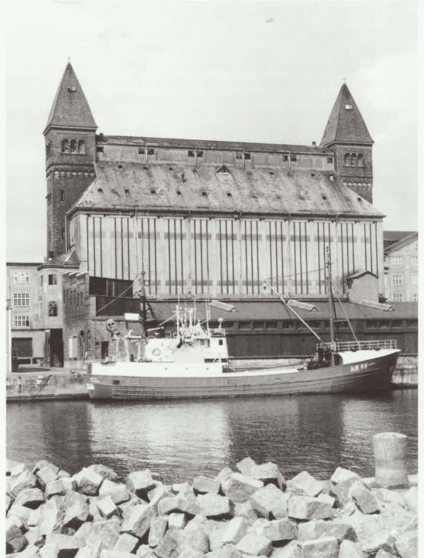
Silopakhus B er opført i 1903 ved arkitekt F.L. Levy og ingeniør C. Agerskov for Københavns Frihavn A/S. Bygningen er opført med den nederste etage i røde sten og en silosektion af profilerede betonskærme. Taget er helvalmet og har en gennemløbende lanterne i rygningen. De flankerende gavltårne har spidstage, beklædt med skifer. Bygningen er meget markant i bybilledet, og kan ses fra mange steder på Østerbro.
