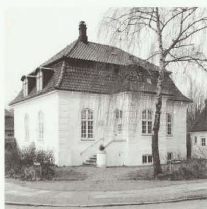
Svanemøllevej 15, opført 1915, er et eksempel på palæstilen i en mere beskeden skala, men bygningen har alle de karakteristiske træk - småsprossede vinduer, sortglaserede tagsten og hvidpudset mur.
