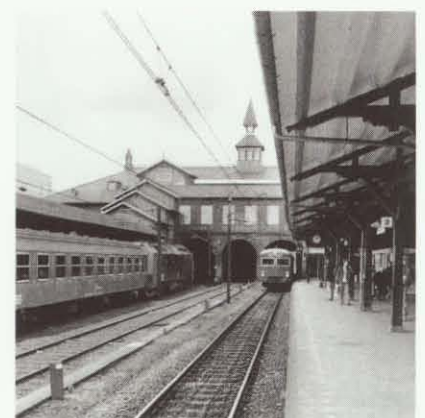
Perronen har smukke konstruktioner
