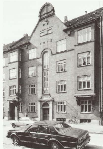
Manøgade 7 er opført 1912 af Ph. Smith. Det klassicistiske hus har renaissance-træk.
