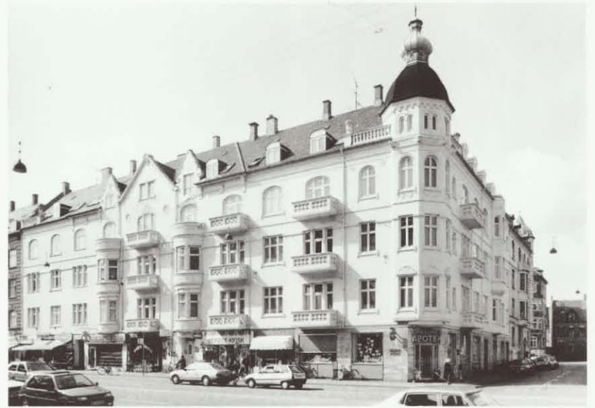
»Øresunds Palæ«, Hornemannsgade 1 er opført 1907. Bygningen er rigt udsmykket med tårn, rækværk med vaser, karnapper og altaner.
