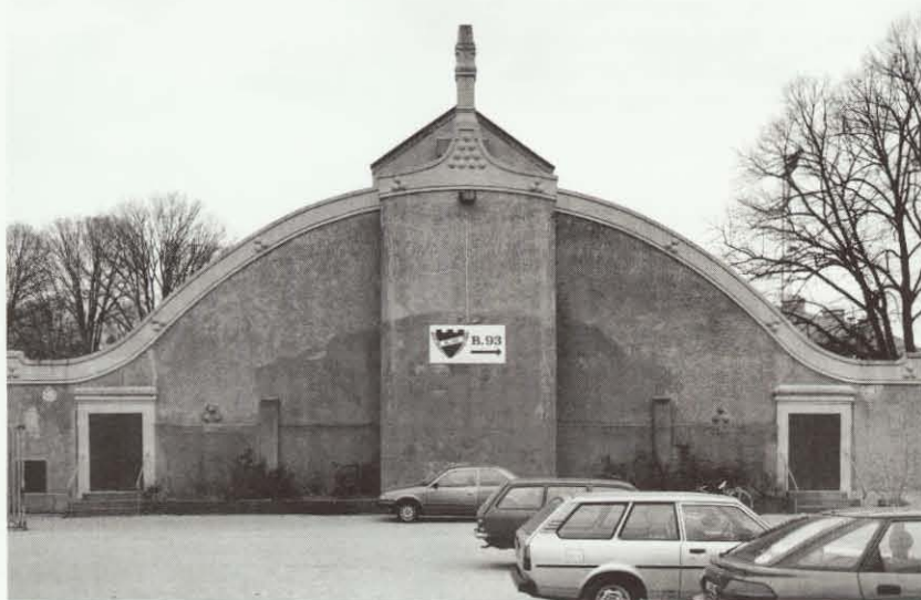
B 93's idrætshal, Ved Idrætsparken 11, er opført 1913. Den smukke og specielt formede bygning er tegnet af arkitekt Søren Lemche
