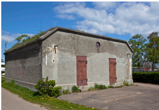
Kulturmiljøet omfatter også en rest af kyststrækningens tidligere militæranlæg.
