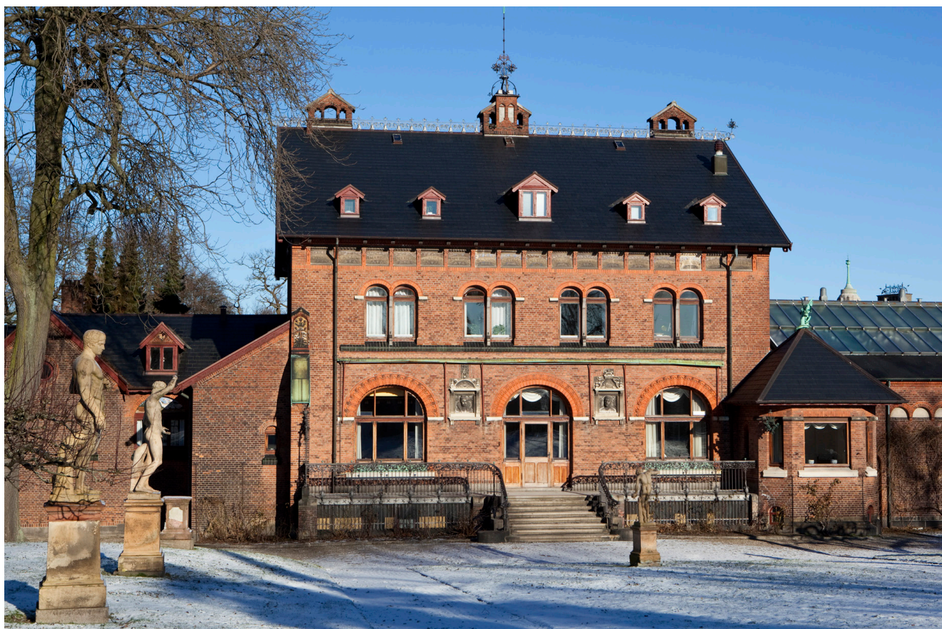
Carls Villa og Carl Jacobsens Villa's Have blev anlagt omkring 1892. Den udgør en værdifuld sammenhængende helhed.
