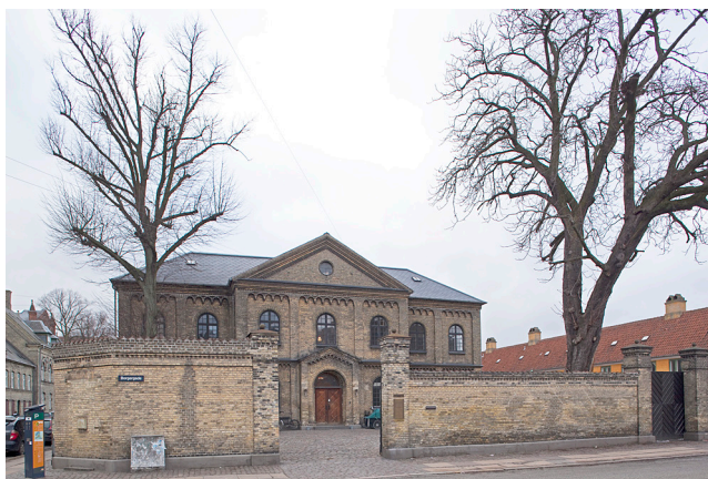
Søetatens Pigeskole blev oprettet som skole for søetatens døtre. Bygningerne rummer store arkitektoniske og kulturhistoriske kvaliteter og er fredet.
