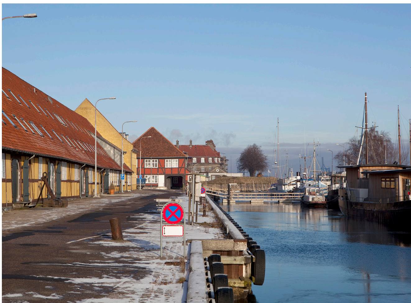
Nyholms fine samspil mellem bygninger, anlæg, vand og landskab.
