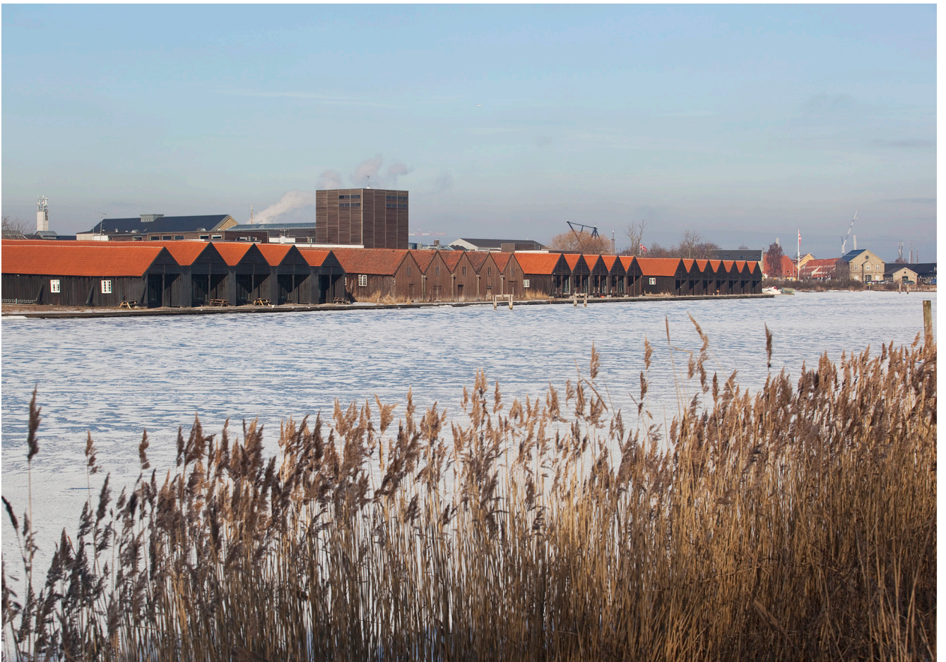
Kanonbådsskurene i sammenhæng med Erdkehlgraven udgør en del af de bærende bevaringsværdier i kulturmiljøet.
