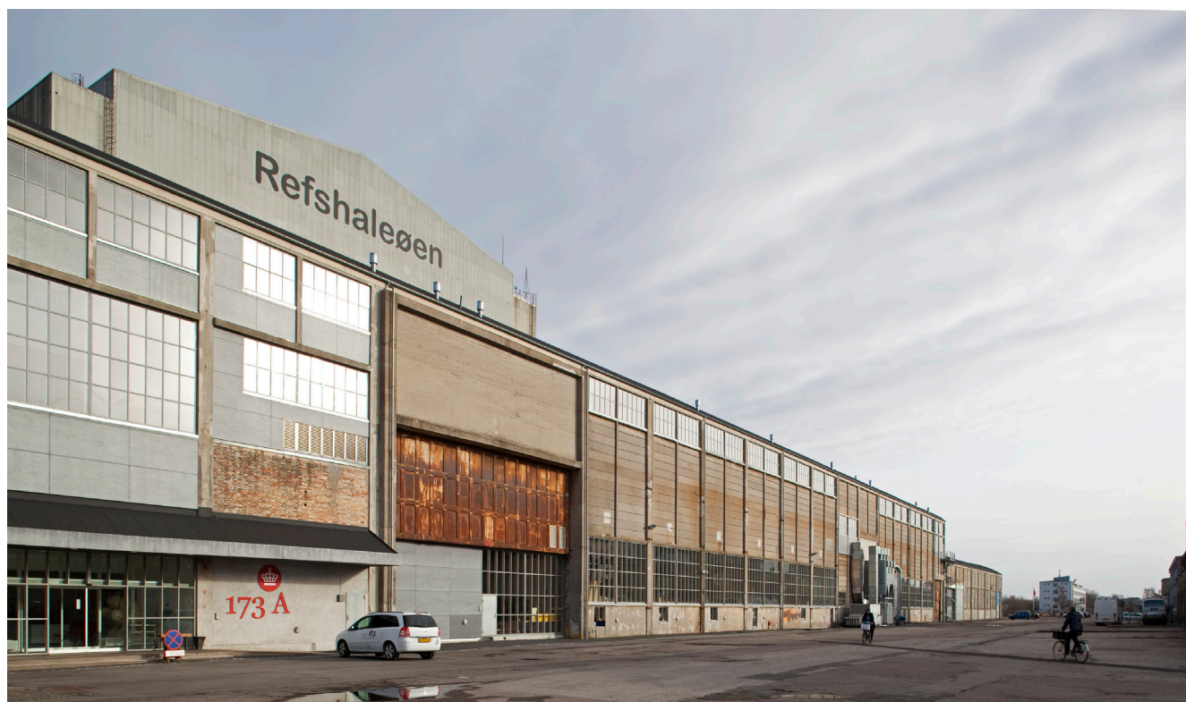
Svejsehallen med sektionshallerne bagved.
