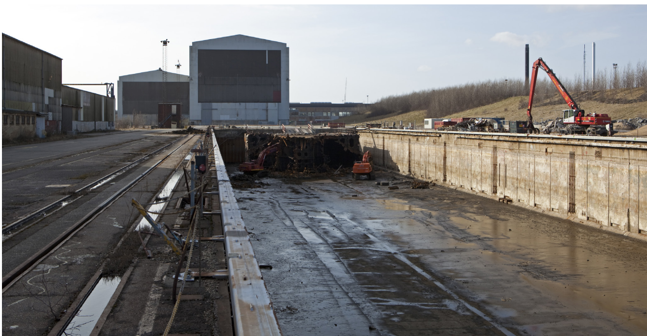
Et kig fra øst med byggedokken fra 1961 i forgrunden, hvor skibene blev færdigbygget. Søsætningen skete ved at den 240 meter og 38 meter brede dok blev fyldt med vand og skibet kunne flyde ud i Øresund.
