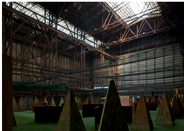
Det indre af den store sektionshal. Den største af hallerne er 150 meter lang, 35 meter bred og 65 meter høj
