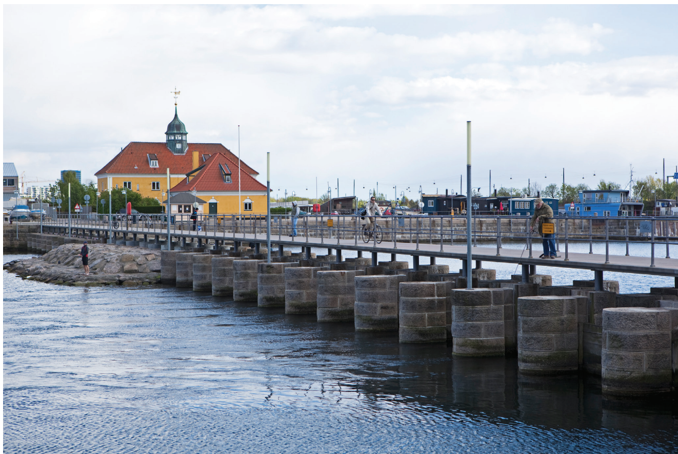
Slusen set fra Sjællandssiden med slusehavnen og sluseanlæggets bygninger bagved
