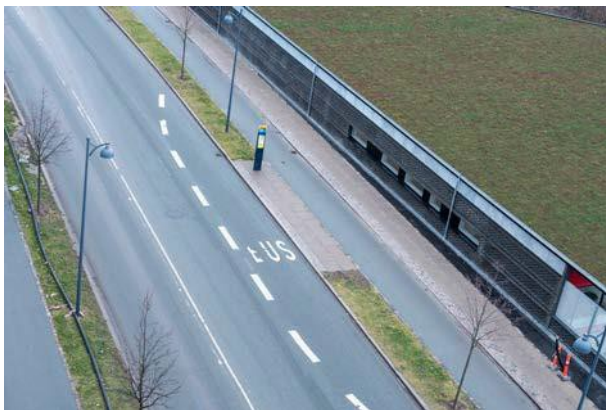
Busholdeplads med hvid afstribning på kørebanearealet
