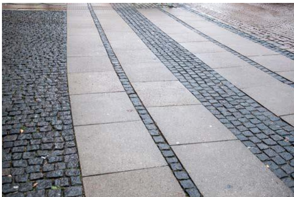
Betonflise i Københavnerfortovet
