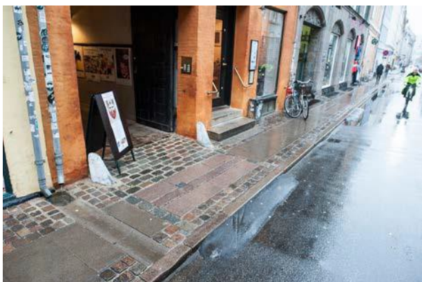
Overkørsel i brosten med gangbane i bordursten
