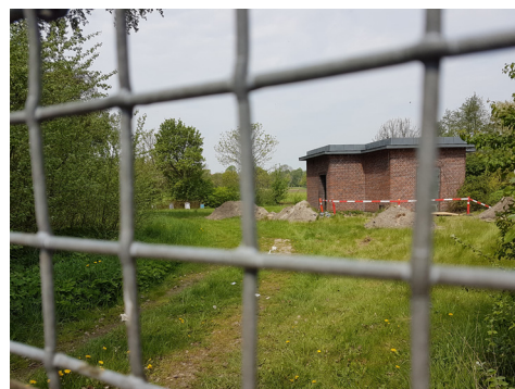
Billede 23: Pumpehusgrunden, som er lukket af for offentligheden
