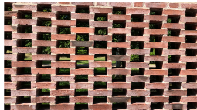
Bearbejdelse af muren ved lommebyrum på Skoleholdervej
