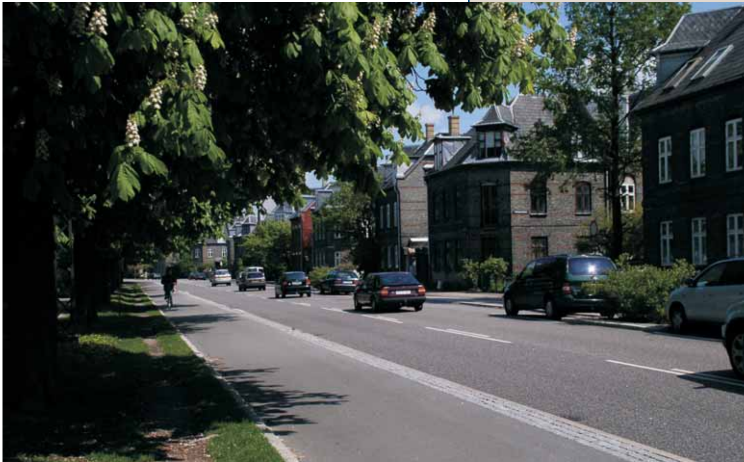
Noise reducing asphalt on Øster Søgade
